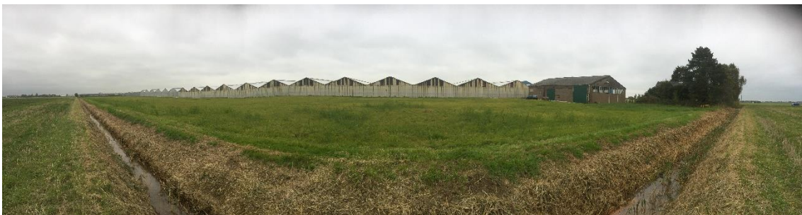
Figuur 10 Foto bestaande bedrijfsbebouwing gezien vanaf de Zesde Tochtweg (bron: VEK Adviesgroep).
