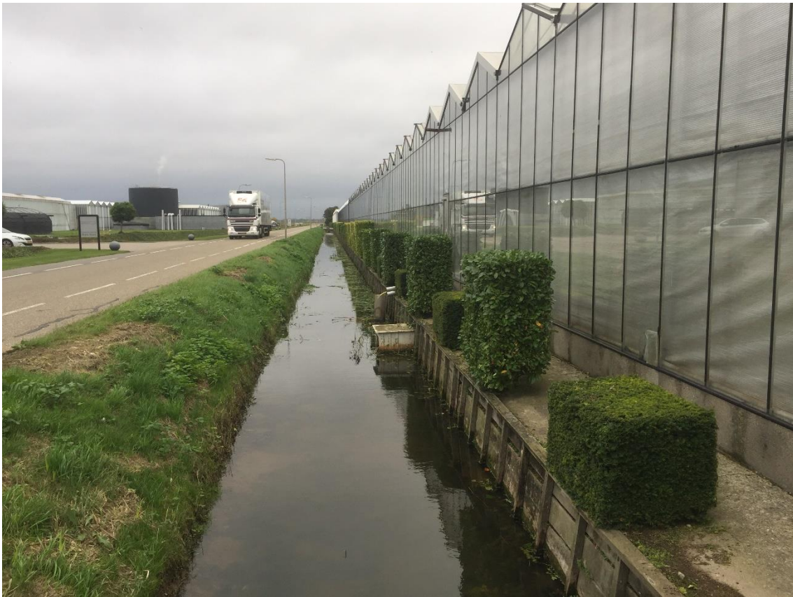
Figuur 4 Foto bestaande glasopstanden vanaf de Abr. Kroesweg (bron: VEK Adviesgroep).
