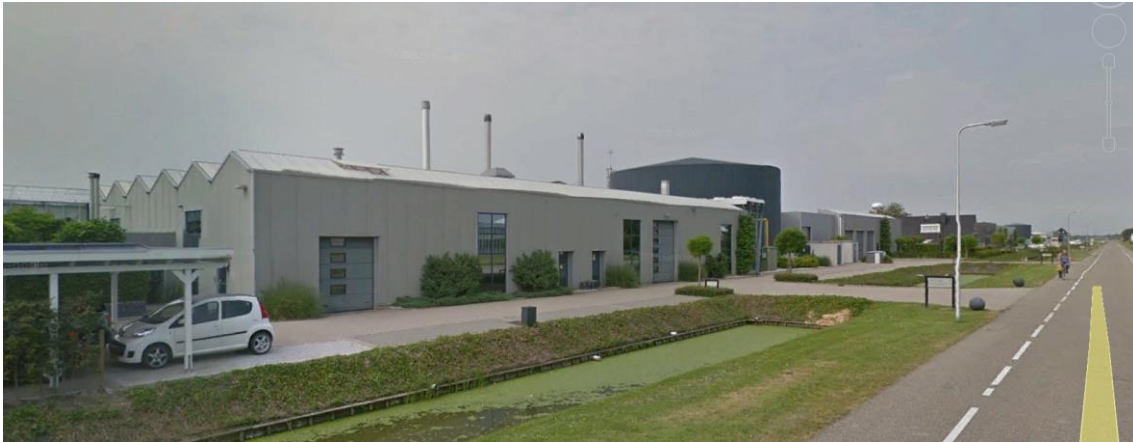
Figuur 8 Bedrijfsgebouwen Porta Nova langs de Abr. Kroesweg (bron: Google Earth).
