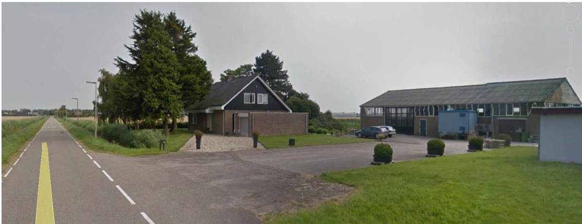
Figuur 11 Foto te slopen schuur aan de Zesde Tochtweg ter plaatse van de nieuw beoogde woning (bron: Google Earth).
