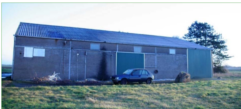
De te slopen schuur in het plangebied.
