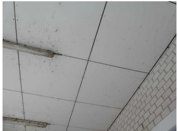
Figuur 6: Afwerking met tresaplaten van overkapping
