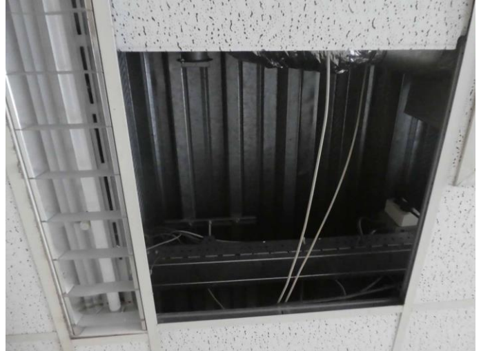
Figuur 4: Dakconstructie met profielplaten
