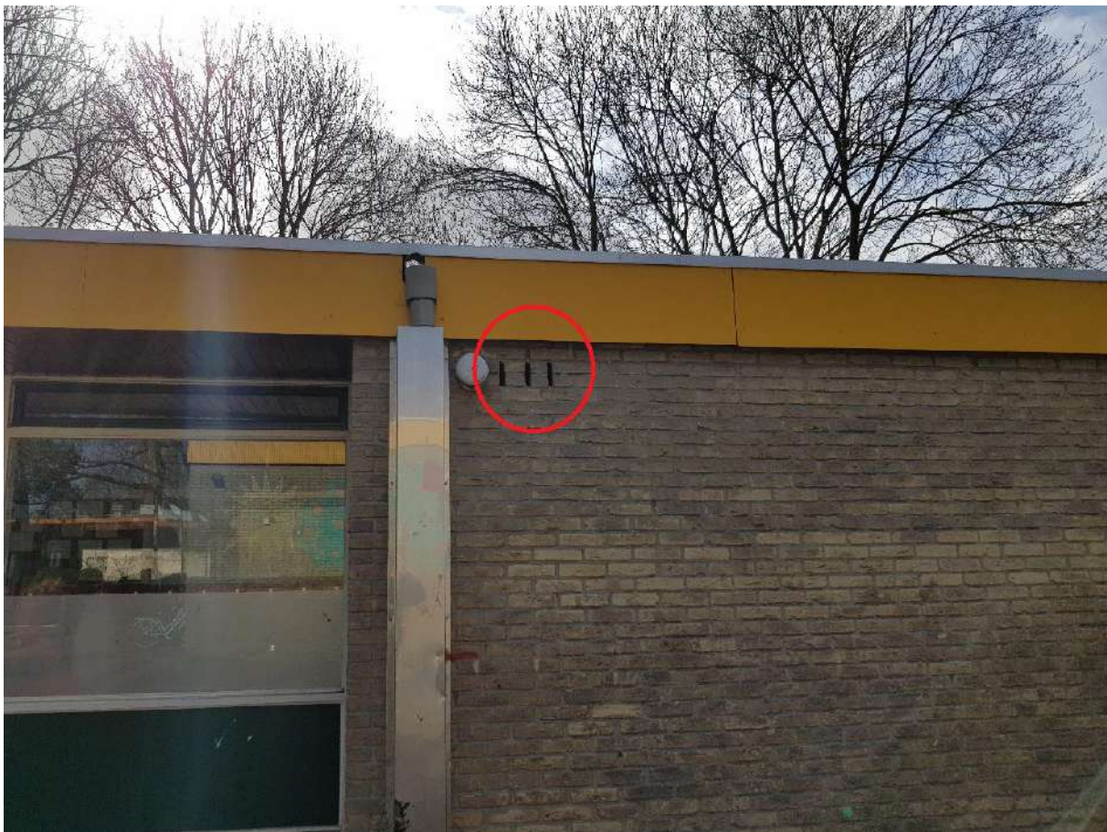
Figuur 4-1. De spouwmuur is op diverse plaatsen bereikbaar via ventilatie stootvoegen(rood omcirkeld).
