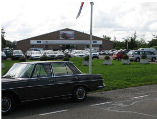
Het te slopen garagebedrijf aan de Onderweg 8.
