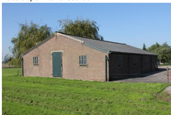
De te slopen varkensschuur.
