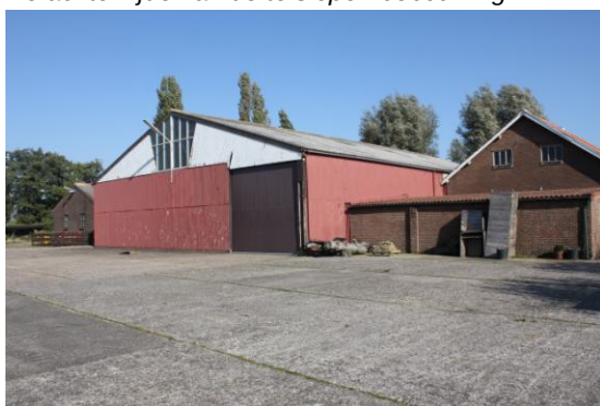
De achterzijde van de te slopen bebouwing.
