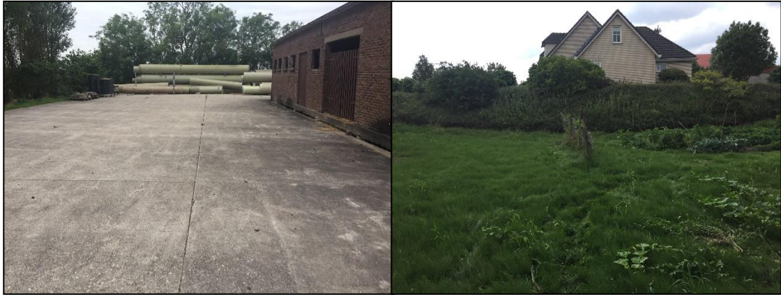
Figuur 12. De linker foto betreft de situatie tussen boorpunten 1 en 2 en de bestaande schuur. Op de rechter foto is het verschil in maaiveldhoogte tussen boorpunt 6 (standpunt) en boorpunt 10 (ter plaatse van woning) goed zichtbaar
