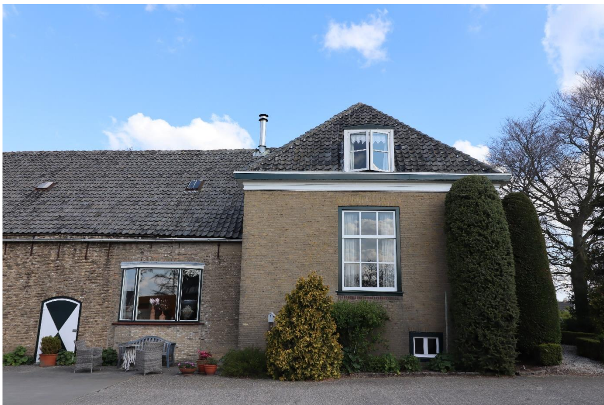
De gevel is op enkele plaatsen grondig vernieuwd, zoals bij de later toegevoegde erker in de rechterzijgevel.
