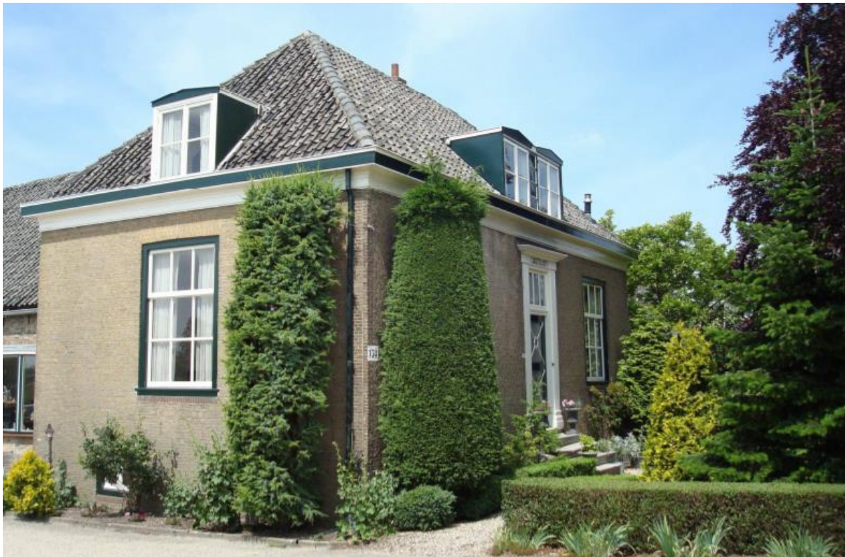
Afbeelding van het bestaande voorhuis. De dakkapellen dateren uit een verbouwing uit 1953. De voorgevel heeft neoclassicistische kenmerken met twee pilasters, bovenlicht en hardstenen verhoogde stoep.
