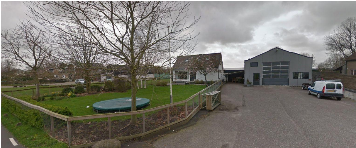
Figuur 2.1: Aanzicht perceel vanaf de Middelburgseweg (bron: google streetview)
