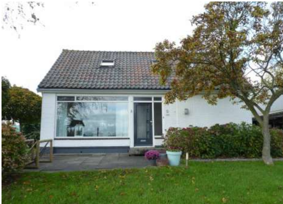
Figuur 2 Te slopen woning
