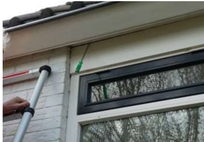
Figuur 19 Geen ruimte kozijn
