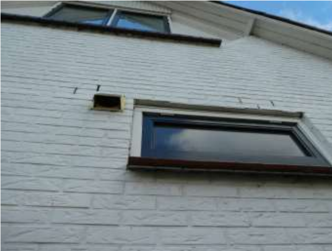
Figuur 21 Open stootvoegen kopgevel bij ventilatie
