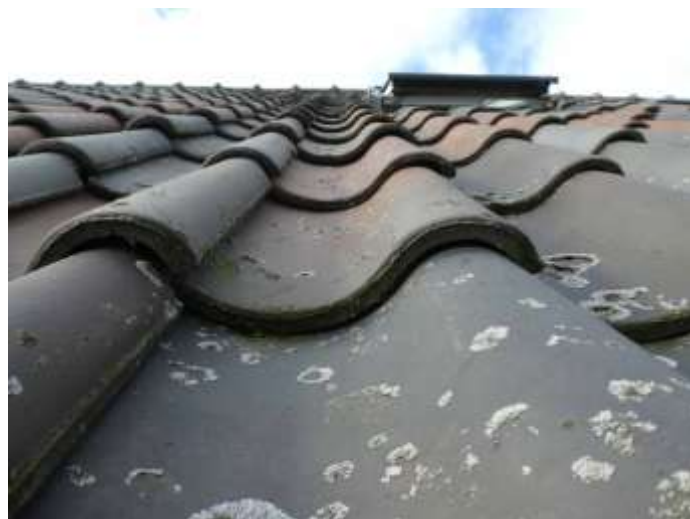
Figuur 14 Close-up dak
