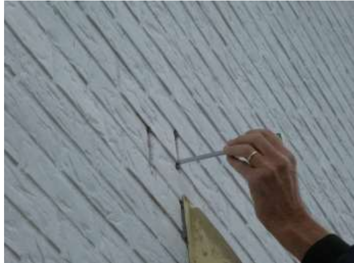
Figuur 22 Inspectie open stootvoegen
