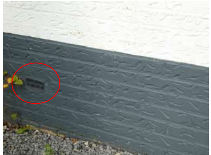
Figuur 23 Ventilatie laag bij de grond zuidelijke kopgevel
