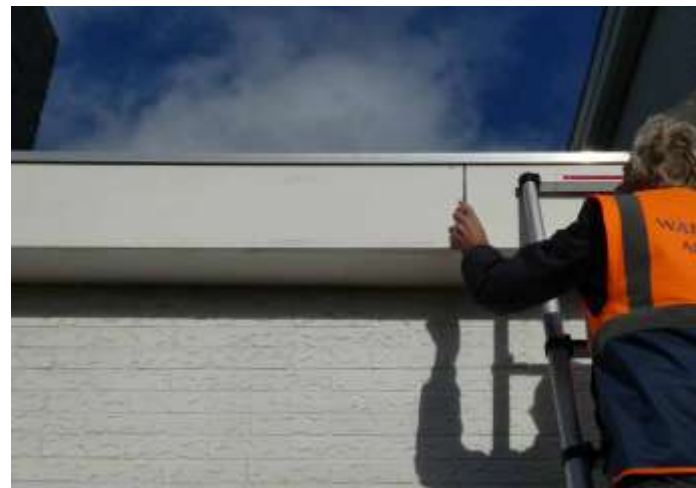
Figuur 17 Geen ruimte metalen daktrim
