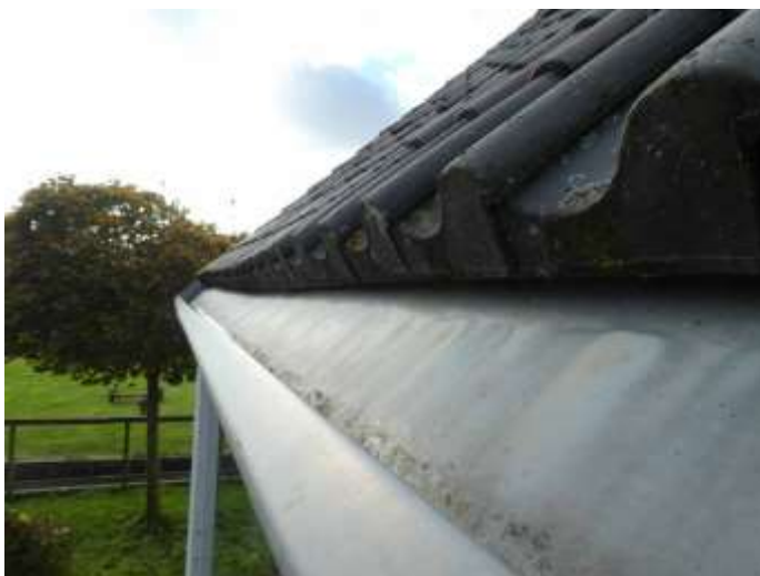
Figuur 15 Detail dak
