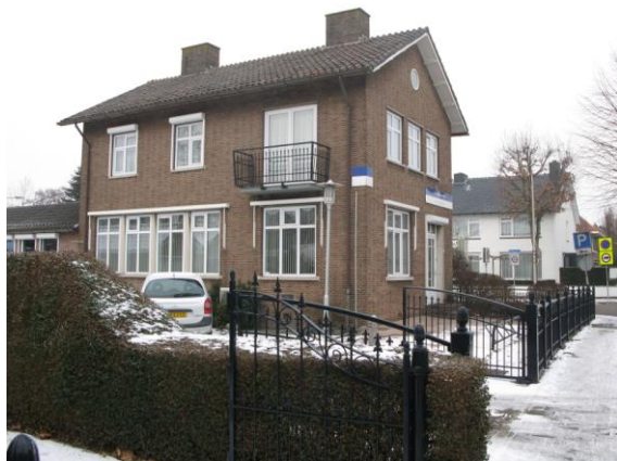
De zuidzijde van het kantoor met ingang.
