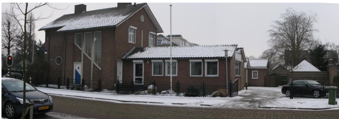
Het kantoorgebouw vanaf de Stationsstraat met inrit naar het binnenterrein.
