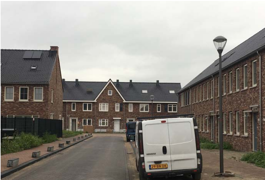
1. een accent in de gevel
