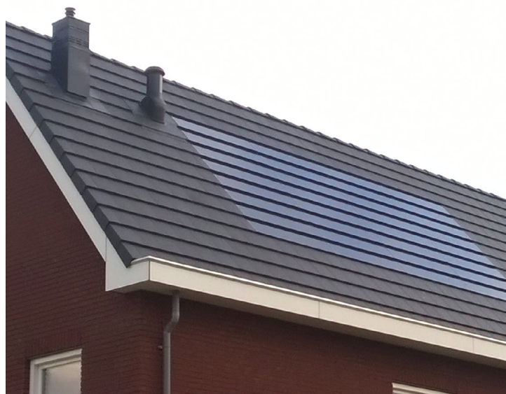
zonnepanelen aan de voorzijde geïntegreerd in het dakvlak en afgestemd qua kleur
