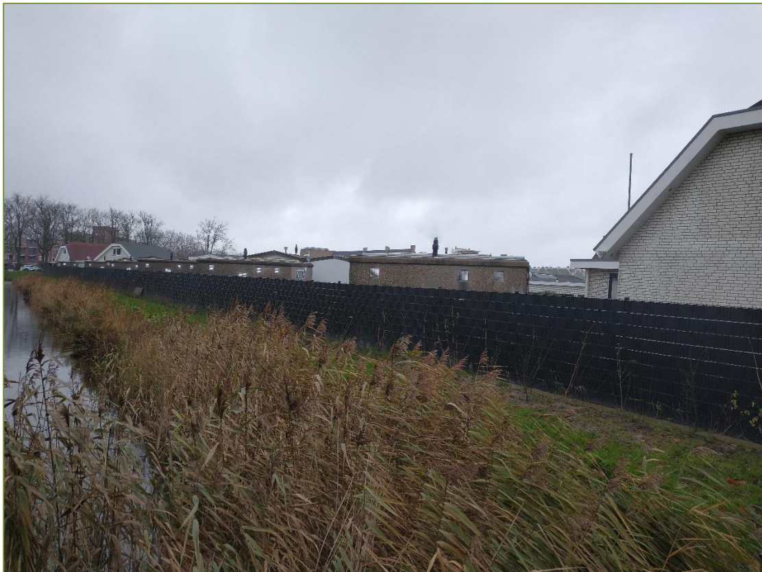
Foto 2 rond het plangebied staat een stenen en ijzerwerk muur. Deze muur is ook de grens van het plangebied. De sloot op de voorgrond ligt buiten het plangebied, maar ligt binnen het onderzoeksgebied en is daarom wel meegenomen in de analyse van het onderzoek.
