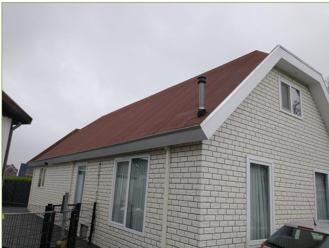
Foto 5: bitumen daken en tot de grond afgesloten muren.
