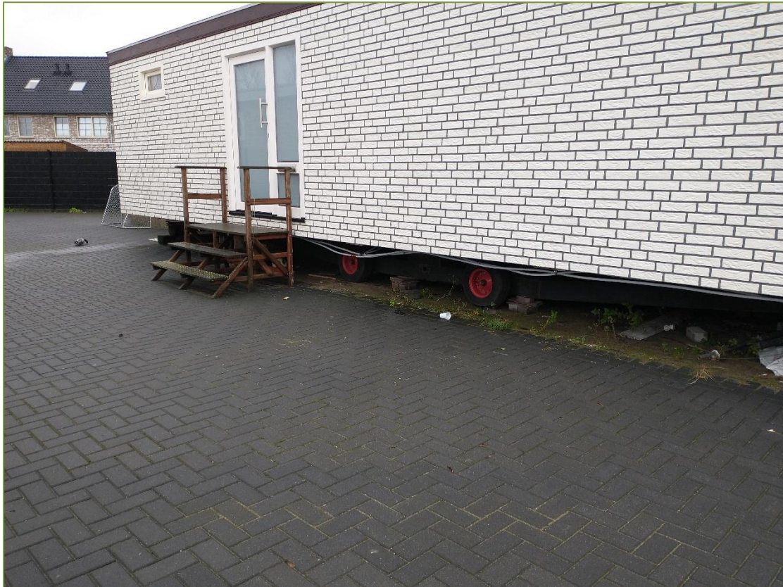
Foto 7: één van de 16 wooneenheden werd aan de binnenzijde verbouwd en was aan de onderzijde nog niet afgesloten. In een groenrijke omgeving zou men hier misschien een zoogdier kunnen verwachten, maar in deze woongemeenschap zonder een sprietje groen, alwaar deze wooneenheid in het midden stond, is dit uitgesloten.
