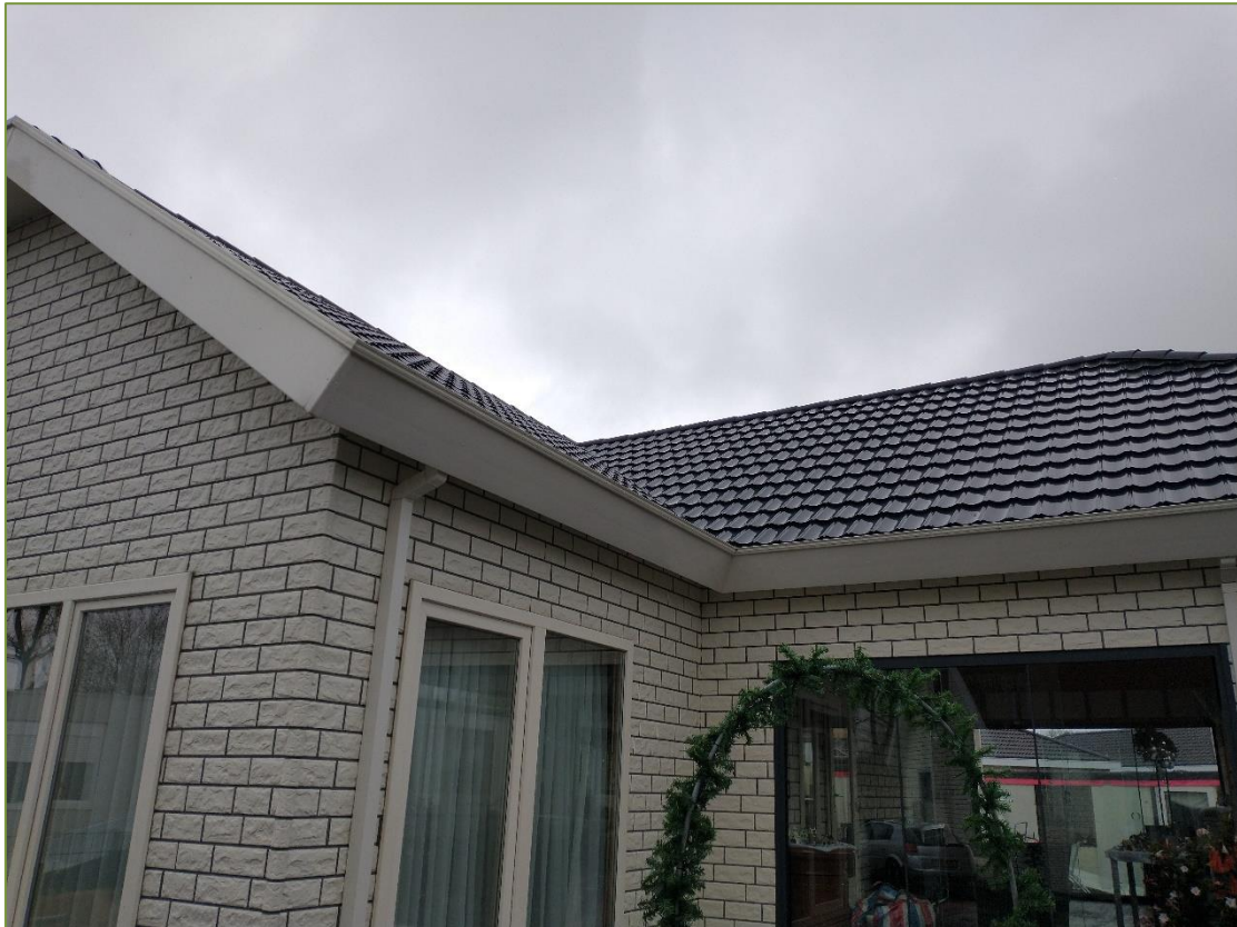
Foto 8: een afbeelding van een wooneenheid met een pannendak. De dakpannen liggen keurig aangesloten en er zijn geen openingen aangetroffen die gebruikt zouden kunnen worden door huismussen, gierzwaluwen of vleermuizen.
