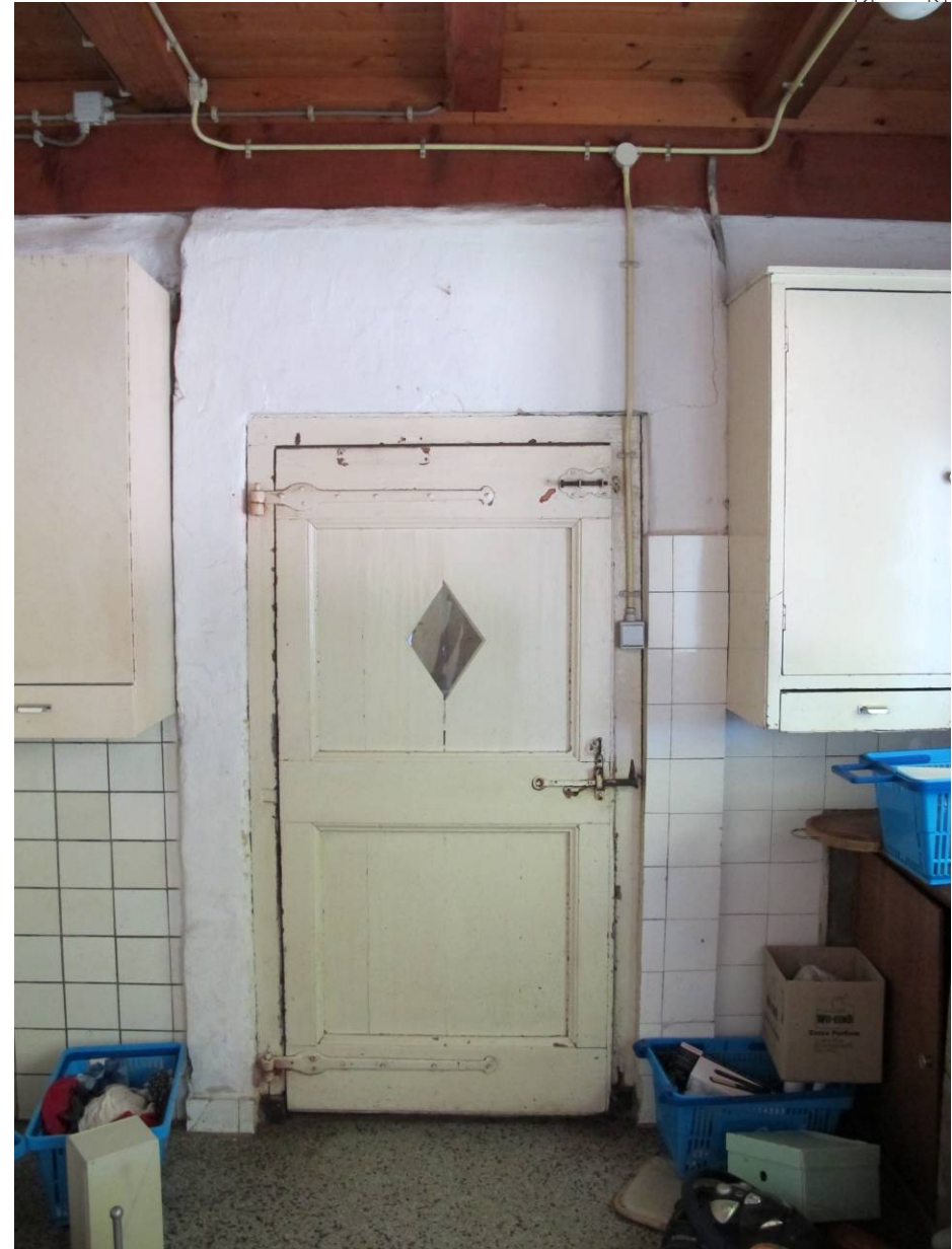
Fraaie opgeklampte deur tussen de bijkeuken en de spoelruimte.
