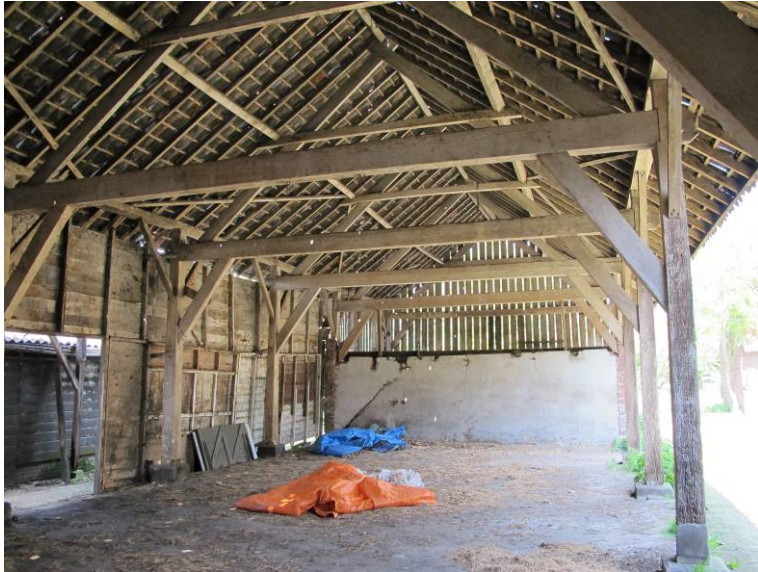
Overzicht van het interieur en de constructie in noordelijke richting.
