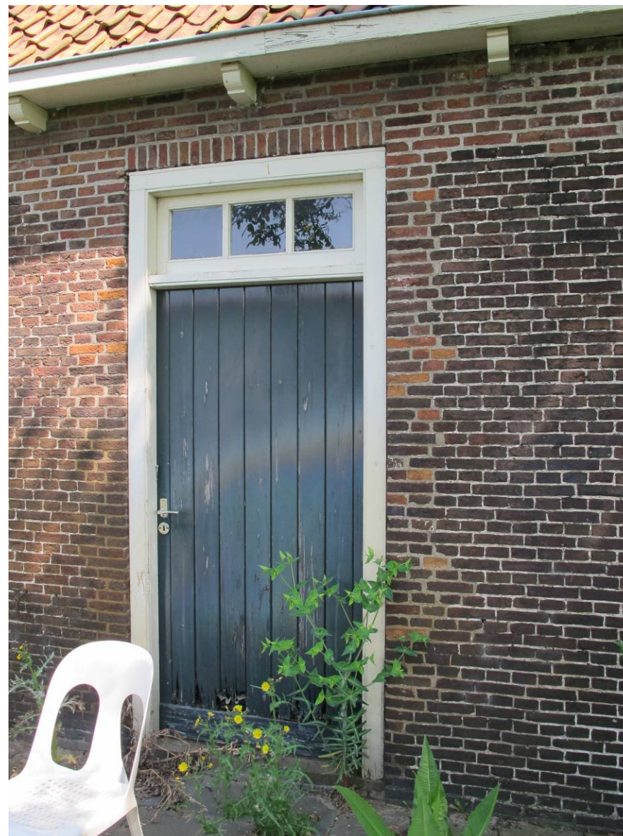
De in 1962 ter plaatse van een venster ingevoegde deuropening.
