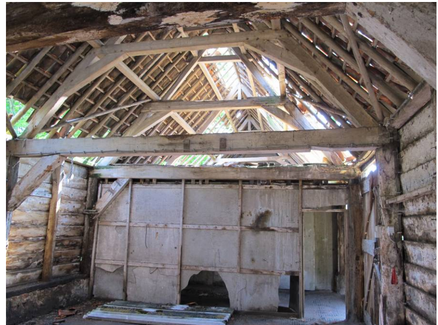
Overzicht wagenschuur richting westgevel.
