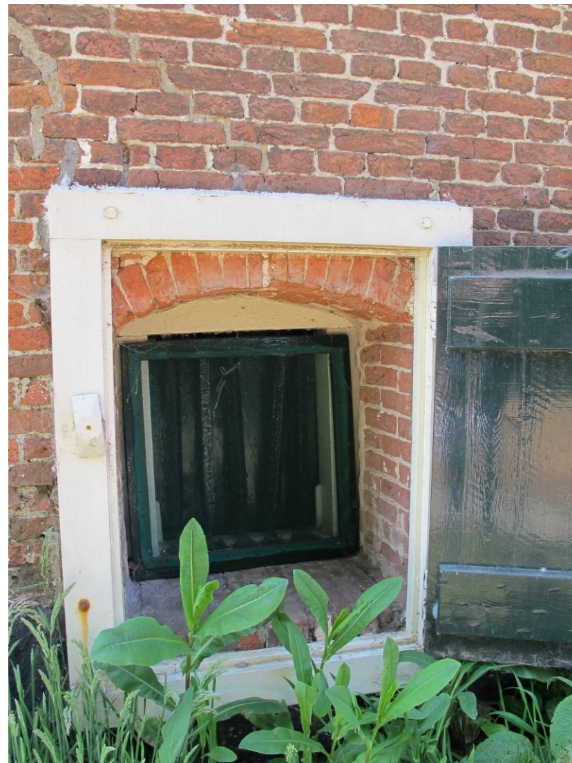
Detail van het kelderlicht in de rechter zijgevel.
