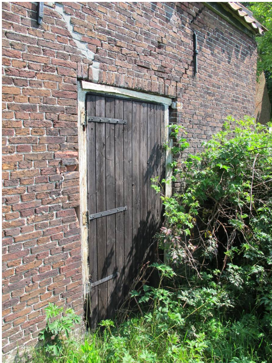
Deuropening in de linker zijgevel van het karnmolenhuis met in het oude kozijn een vernieuwde deur.
