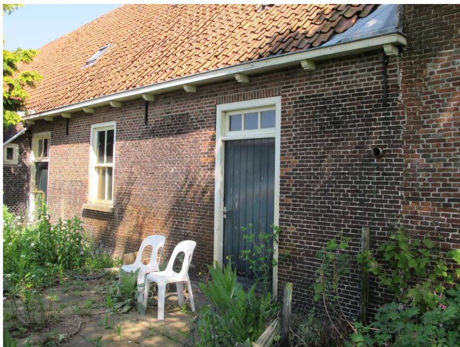
Overzicht van het rechter deel van de linker zijgevel van het achterhuis. Geheel rechts is nog juist een deel van het voorhuis zichtbaar.
