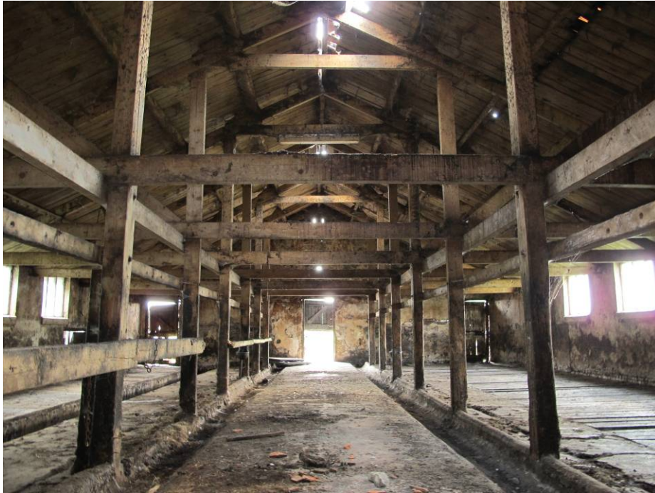
Interieur van de grupschuur, met rechts de latere roostervloer.
