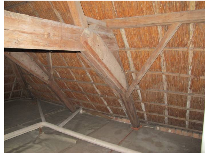
Voorste spantbenen van de twee noordelijke spanten.
