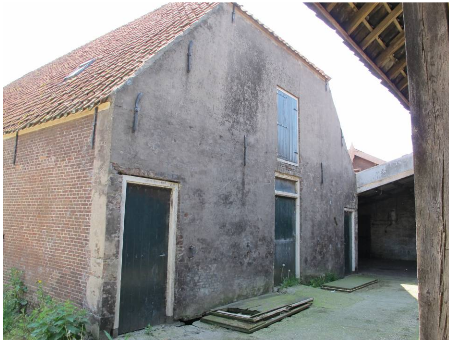
Overzicht van de geheel gepleisterde achtergevel.
