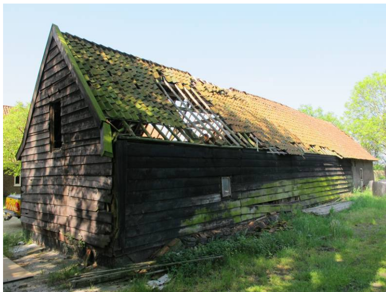
Overzicht van de noordgevel, met op de achtergrond het gemetselde deel.
