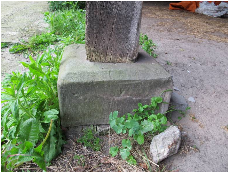
Zandstenen blok onder de gebintstijlen tegen optrekkend vocht.
