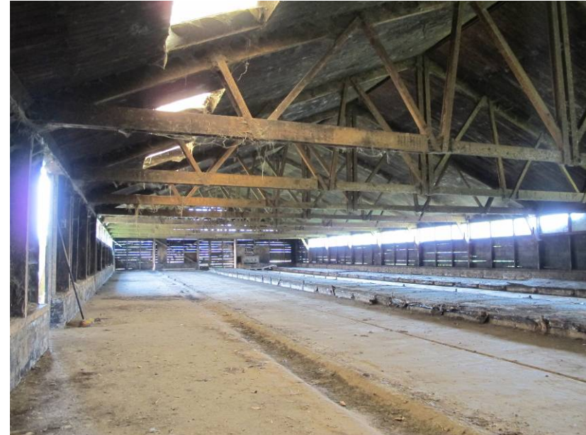
Overzicht van het interieur van de ligboxenstal, gezien richting zuidgevel.
