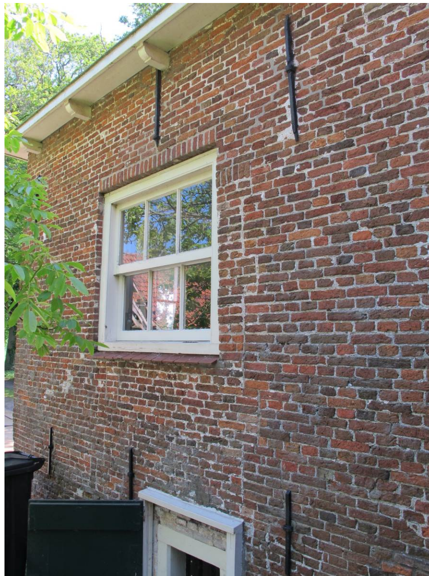
Overzicht van de achtergevel met het in een dichtzetting geplaatste venster uit 1962. Ter hoogte van de opkamervloer zijn inboetingen van het aanbrengen van de balklaag zichtbaar.
