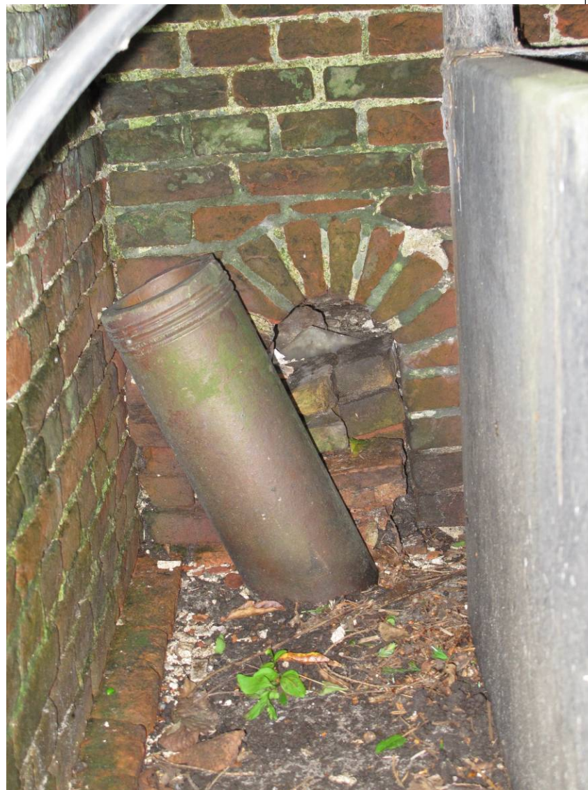
Kleine getoogde opening in de achtergevel, direct naast de zijgevel (links) van het achterhuis.
