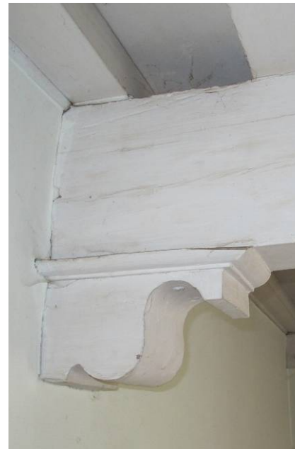
Het hangbuik-ojiefsleutelstuk en de restanten van de korfbogen vormen belangrijke zichtbare kenmerken van de vroegste fase.
