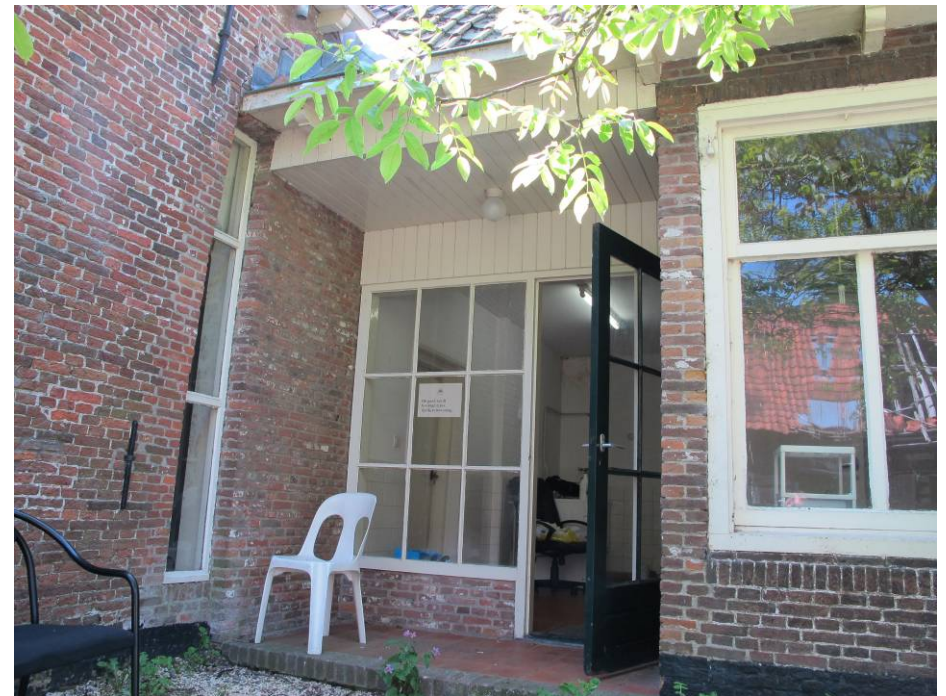
Het in 1962 vernieuwde rechter deel van de achtergevel van het voorhuis. Toen werden een portaal en een verticaal trappenhuisvenster aangebracht.
