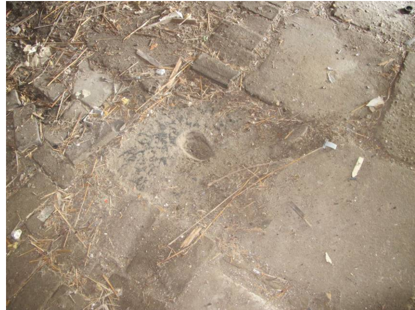
Hardstenen blok met sparing t.b.v. de as van de karmolen.
