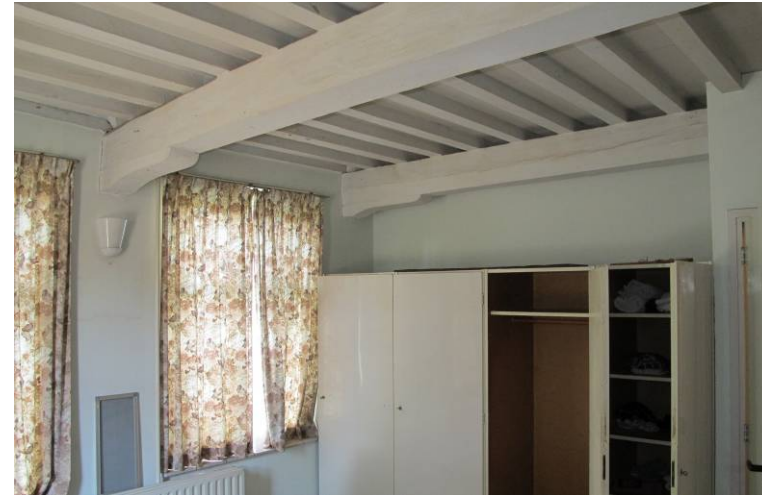
De twee moerbalken boven de voorste opkamer. Bij de aansluiting op de voorgevel (links) zijn zeer sobere sleutelstukken aanwezig.
