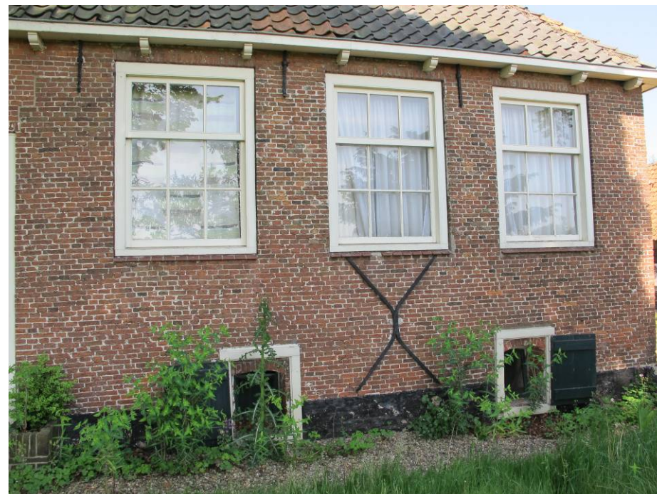
Overzicht van het onderkelderde gedeelte. Tot 1962 was alleen het middelste venster aanwezig.
