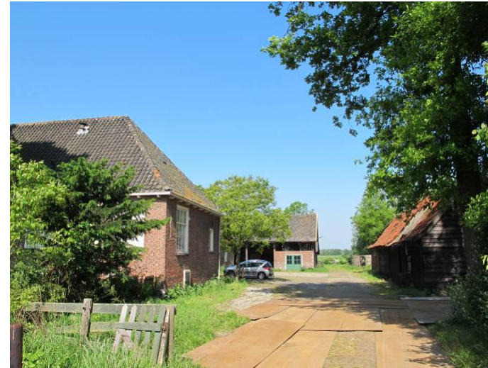
Toegang tot het erf, met links de boerderij, op de achtergrond de hooischuur, rechts de bijshuur en geheel rechts het begin van de oude toegangslaan.
