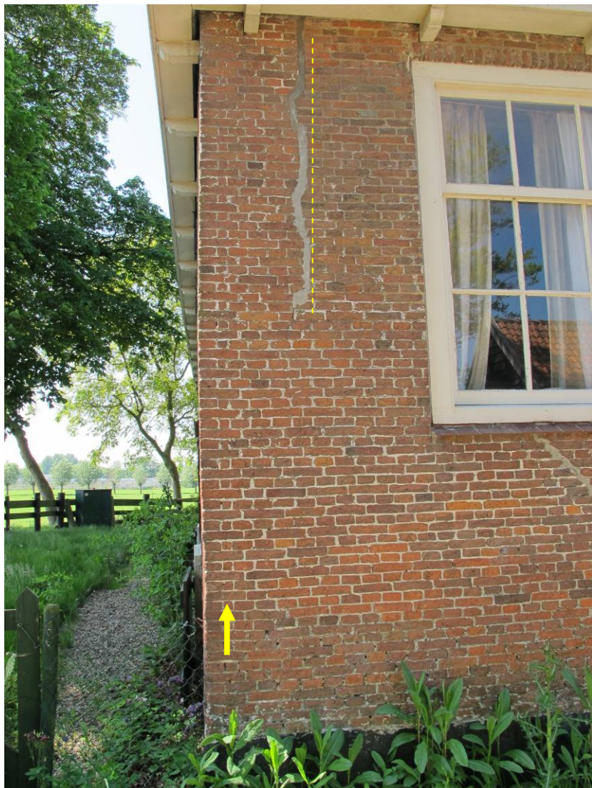
Linker gevelhoek van de rechter zijgevel. De pijl markeert de hier toegepaste klezootjes. De stippellijn markeert de linker dagkant van een oorspronkelijk kloosterkozijn.
