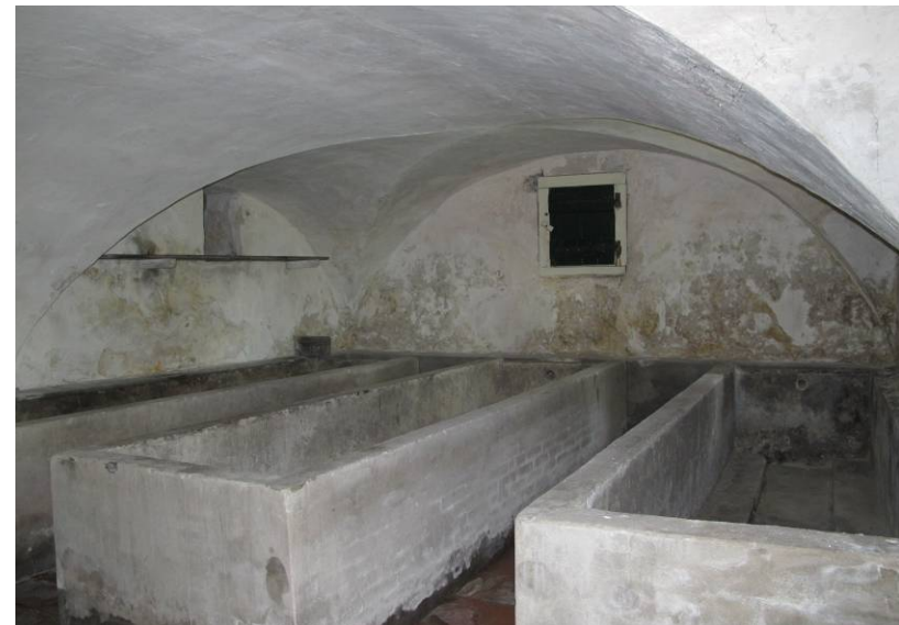
Voorste kelderruimte met kruisgewelven.
