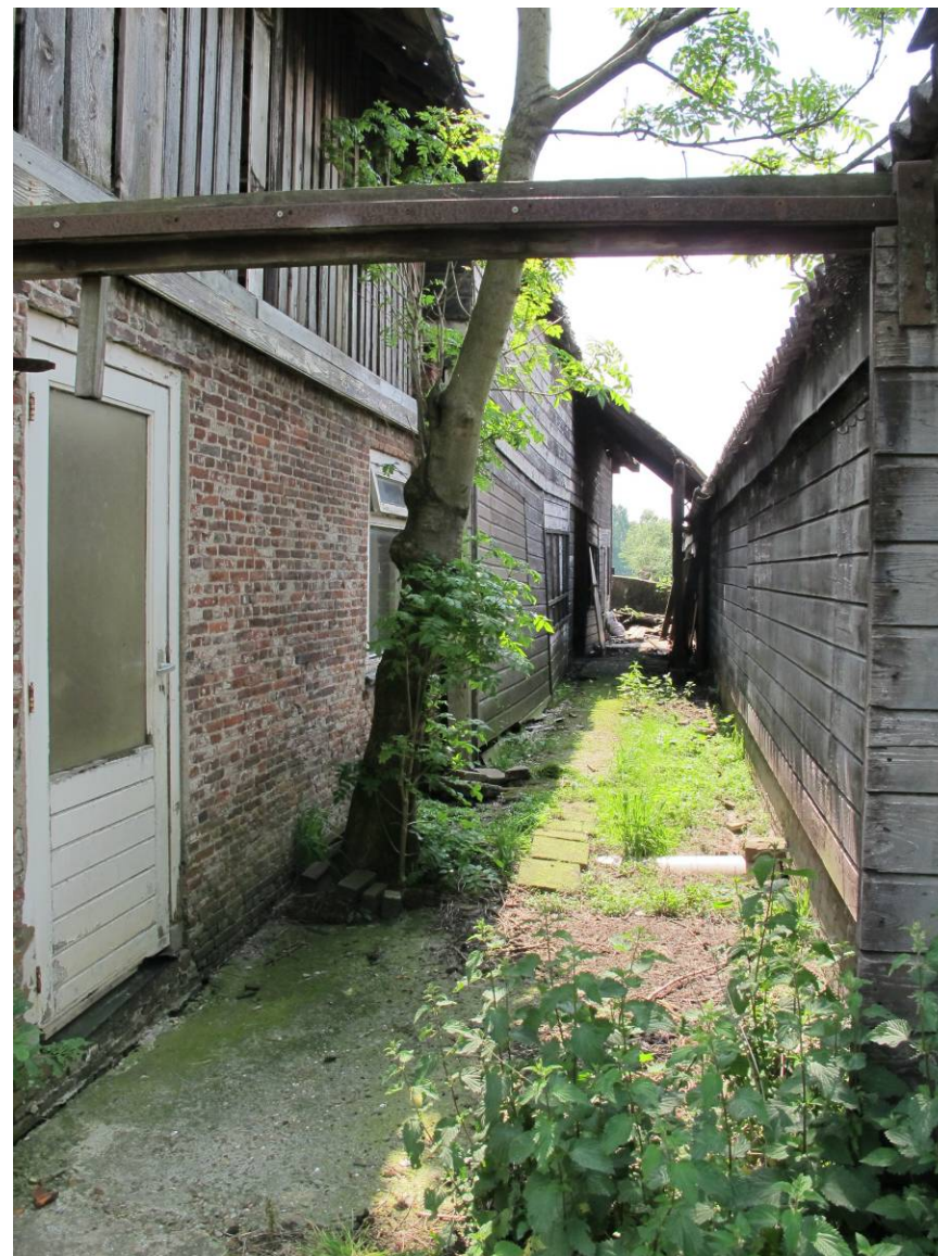
Zicht langs de uit divers hergebruikt materiaal samengestelde achtergevel (links), met boven de doorgang naar de ligboxenstal (rechts) een aankapping.
