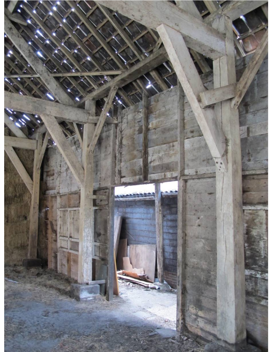
Detail van de gebintstijlen bij de achterwand (west)
