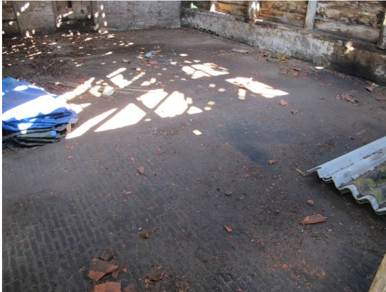
Bakstenen bestrating in wagenschuur
