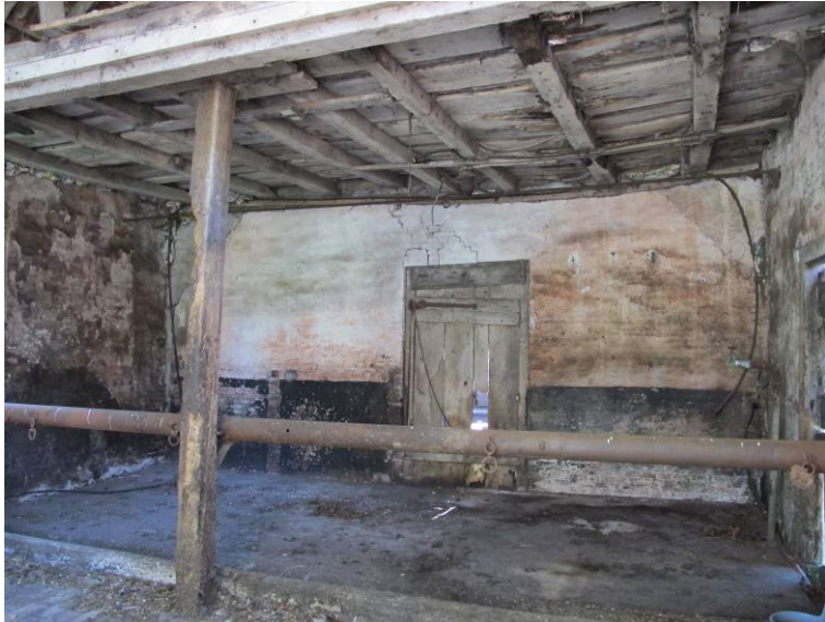
Interieur van de oostelijke stal, gezien richting westgevel.
