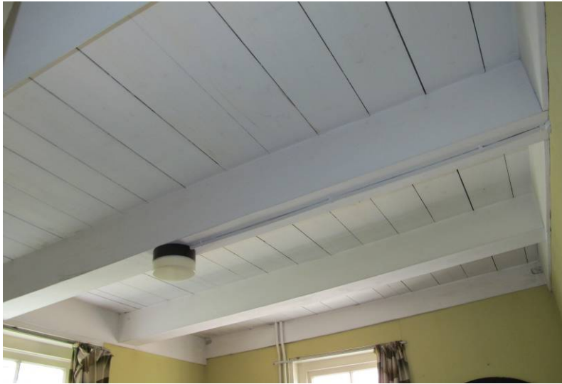
Enkelvoudige balklaag boven de achterste opkamer.
