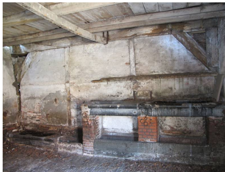
De westwand van de paardenstal, met tegen de vakwerkwand een rij hardstenen voerbakken.
