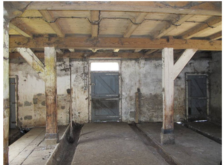
Overzicht draagconstructie in het achterste deel van het achterhuis.
