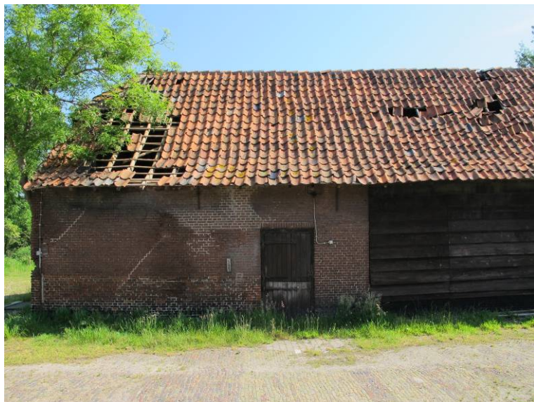
Het in baksteen uitgevoerde westelijke deel van de zuidgevel.
