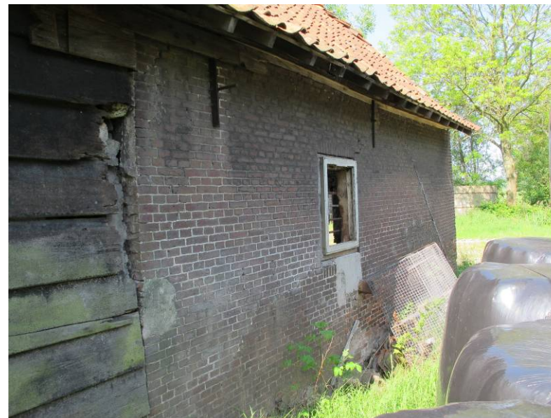
Venstertje in gemetseld westelijk deel van de noordgevel.
