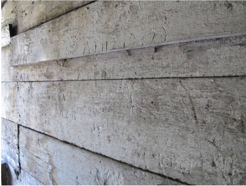
Detail van de houten westwand van de paardenstal, met inscripties.
