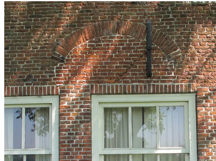
Detail van de 17de-eeuwse segmentboog boven de in 1962 ingevoegde vensters.
