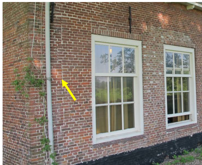
Linker deel van de voorgevel met vlak naast de gevelhoek het ingekaste (pijl) 18de-eeuwse muurwerk.
