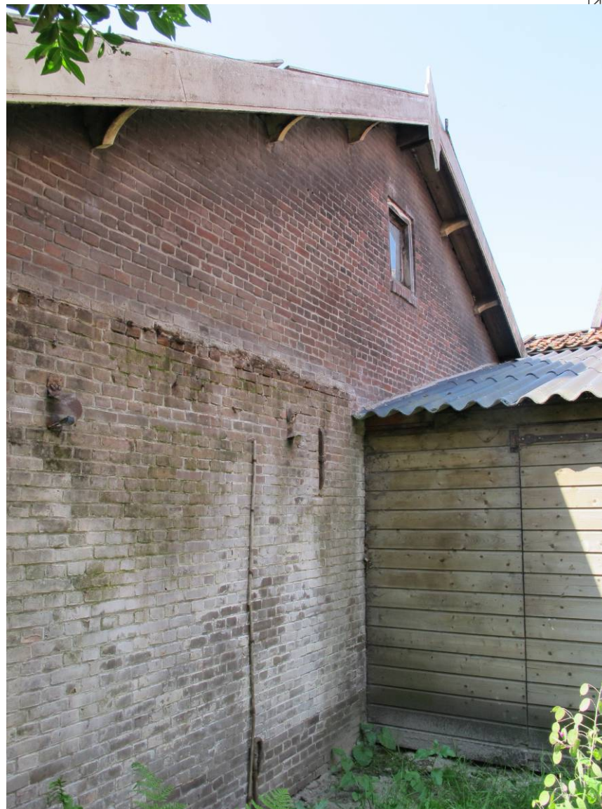
Deel van de noordgevel, met rechts het jongere verbindingslid tussen de boerderij en de grupschuur.
