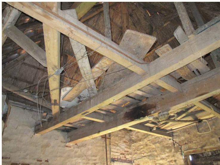
Houtconstructie, behorend bij de karmolen. Bij de pijl sloot de as aan.
