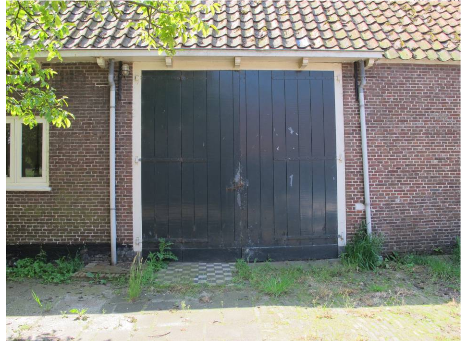
De in 1980 ingevoegde deeldeuren.
