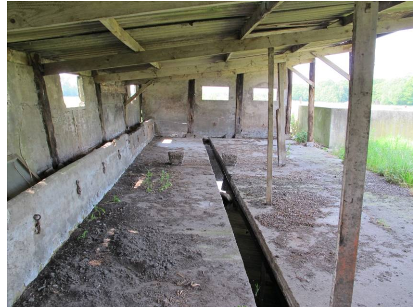
Interieur van de open loods, gezien in westelijke richting.
