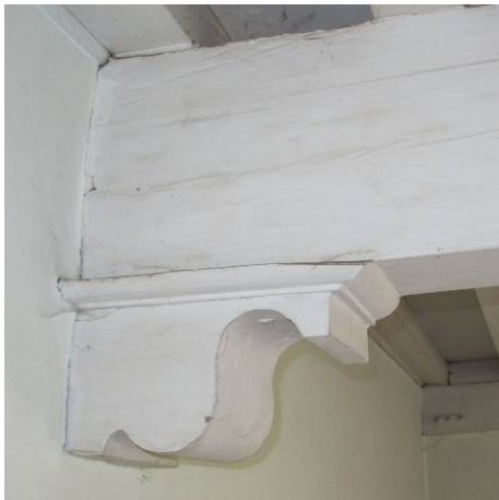
Detail console onder westzijde noordelijke moerbalk.
