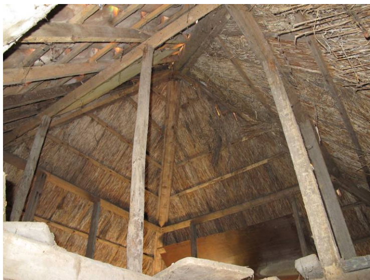
De dakconstructie van het karmolenhuis.
