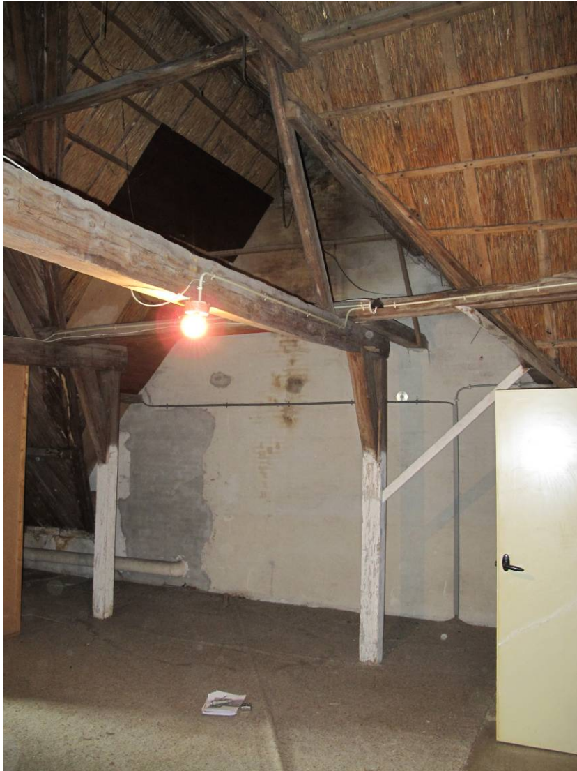
Verticaal geplaatste spantbenen aan de achterzijde van de twee zuidelijke spanten.
