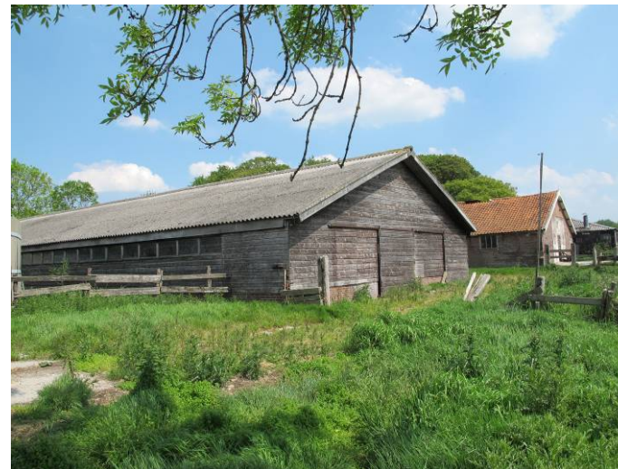
De zuidwesthoek van het erf met de houten ligboxenstal. Geheel links is nog juist een hoek van de betonnen mestlo zichtbaar.
