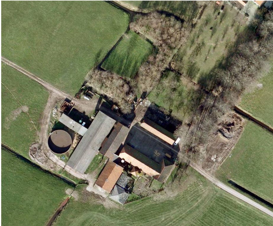
Overzicht van het erf en de aanwezige bouwdelen. Rechtsonder is de huidige toegangsweg zichtbaar Bron: maps.google.nl
