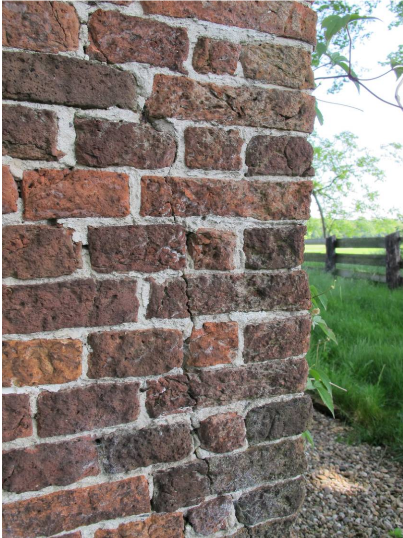
Detail van de hoekoplossing met klezoortjes en het mogelijk oorspronkelijke voegwerk met een daggestreep.
