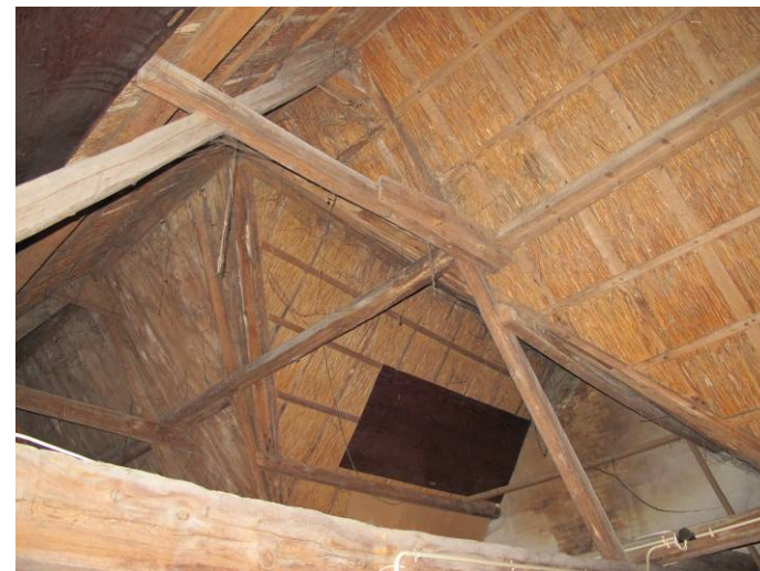
A-spant ter hoogte van de aansluiting op de kap van het achterhuis.
