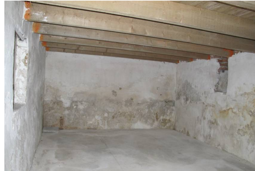
Achterste kelderruimte met in 1962 vernieuwde enkelvoudige balklaag.
