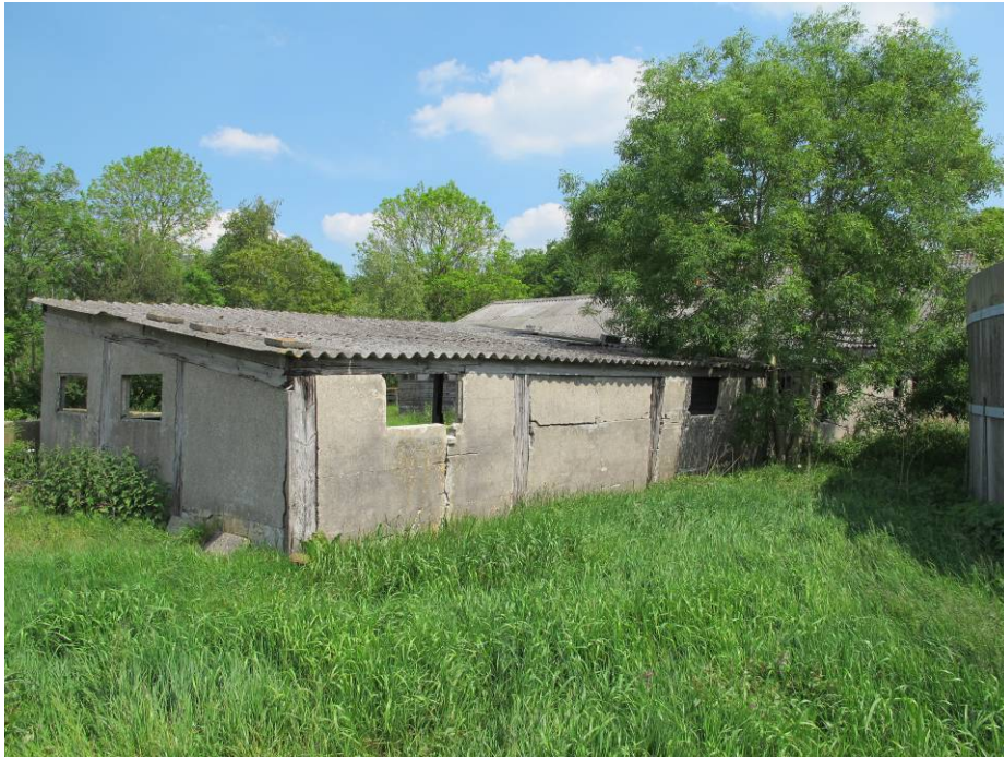
Overzicht van de open loods, vanuit het zuidwesten.
