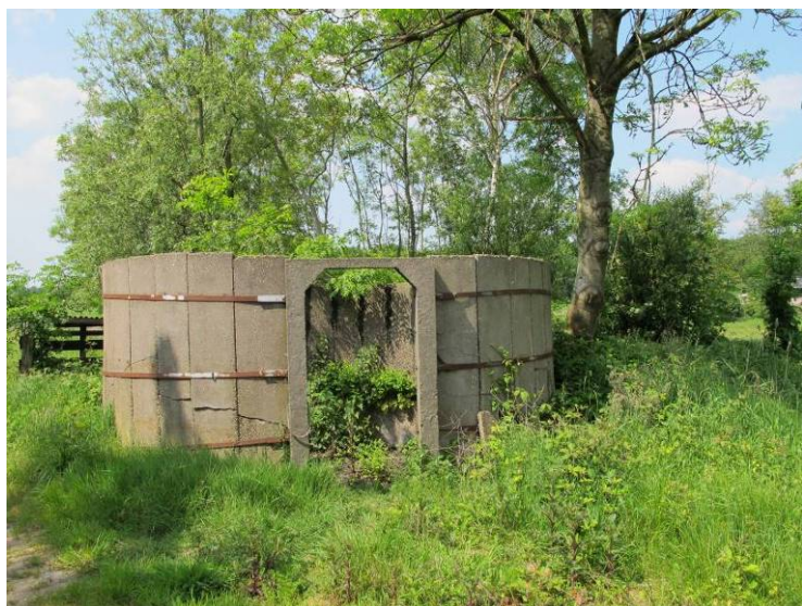
Betonnen silo ten noordoosten van de ligboxenstal
