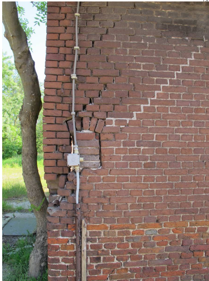
Toegang kippenhoek, direct naast de westelijke gevelhoek.
