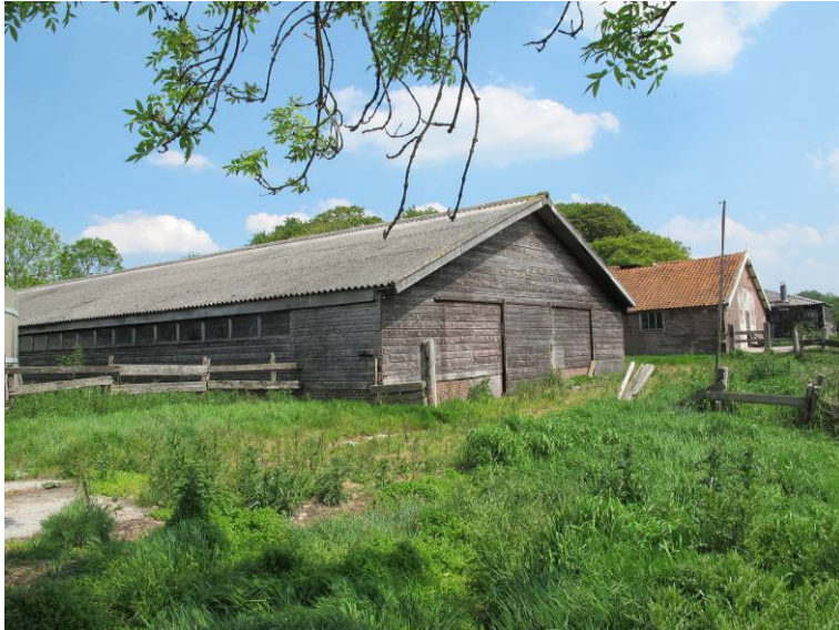
Overzicht ligboxenstal vanuit het zuidwesten.
