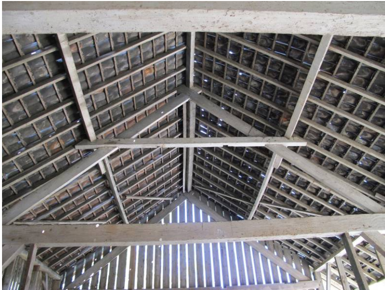
Detail van de op de gebinten geplaatste A-spanten.
