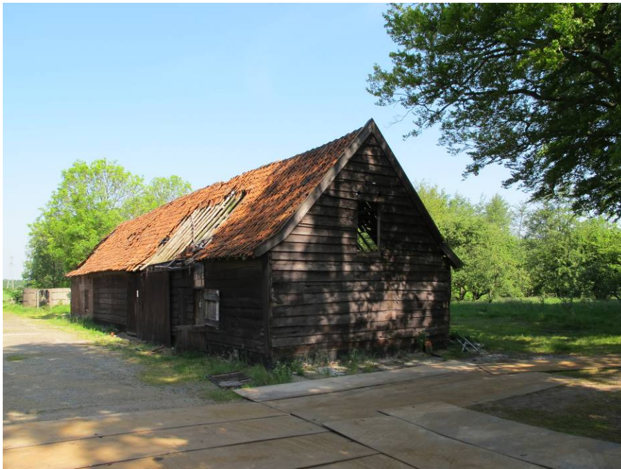
Overzicht bijsschuur vanuit het zuidoosten.
