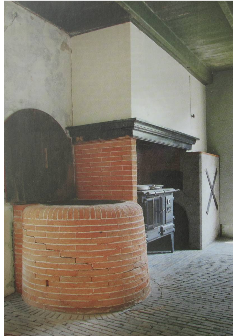
Het interieur van de werkkeuken van Laan van Koot 20 tijdens de restauratie in 2006. Op de voorgrond bevindt zich het waterfornuis, dat ook tot 1962 in de Grenshoeve aanwezig was. Bron: Boerenerfgoed 2006.
