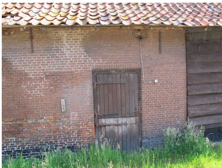
Toegangsdeur in het gemetselde geveldeel.
