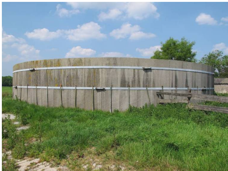
Grote mestsilo op de zuidwesthoek van het erf.
