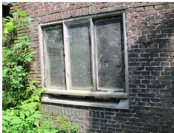
Detail van het linker stalvenster, met daarboven- en onder een smallere halfsteens rollaag.
