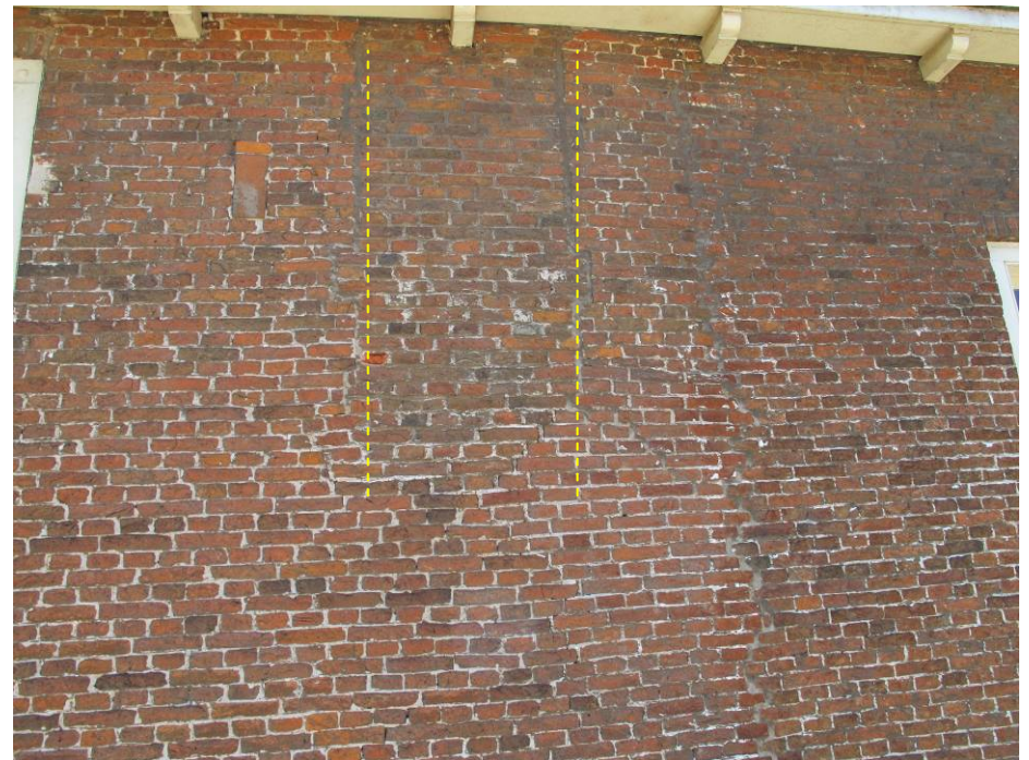
Middendeel van de rechter zijgevel. De stippellijn markeert de plaats van een oorspronkelijk kloostervenster.
