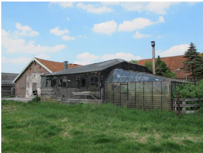
De bebouwing aan de zuidzijde van het erf, met op de voorgrond de deels tot werkplaats omgevormde kas met stookruimte en daarachter de grupschuur.
