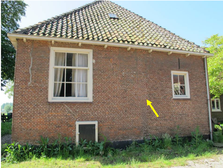
Overzicht rechter zijgevel. Ter hoogte van de pijl bevindt zich de bouwnaad.
