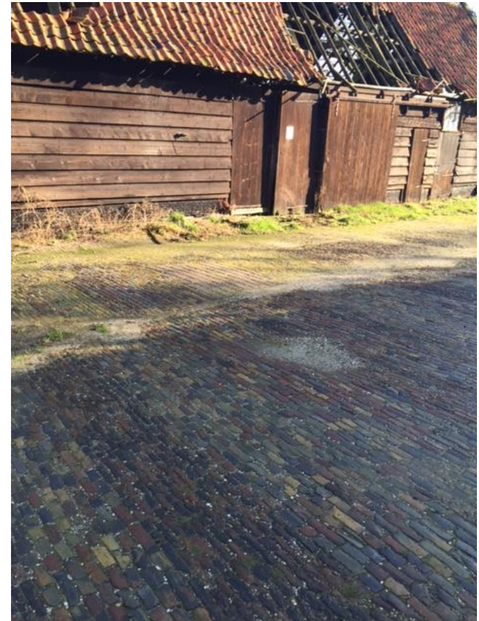
16. Bestaande klinkerbestrating erf
