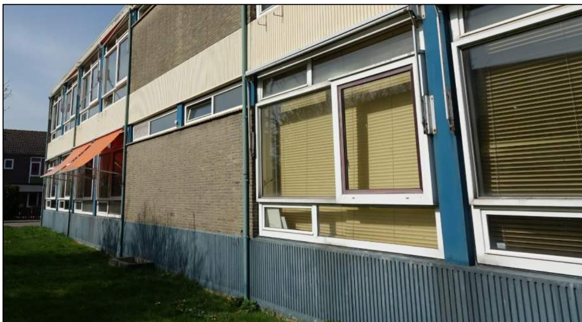
Figuur 7: Zijgevel van het opstal opgetrokken uit baksteen en platen waar alles, inclusief kozijnen, goed aansluit.
