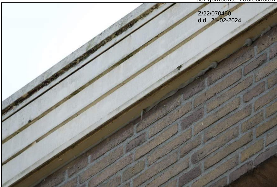
Figuur 8: De dakrand is met kit afgewerkt op de bakstenen gevel zodat er geen ruimte ontstaat.
