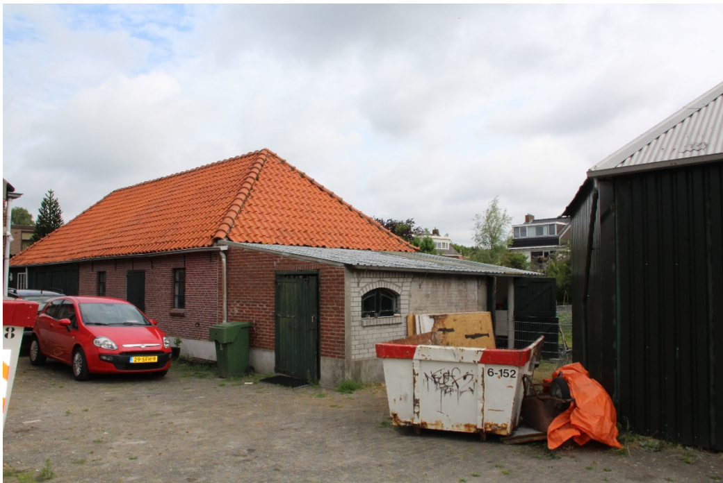
Figuur 4 Het terrein aan de achterzijde van deze schuur was niet toegankelijk tijdens de inventarisatie. Daardoor is de potentie van dit gebouw aangaande vleermuizen en beschermde muurflora onduidelijk.
