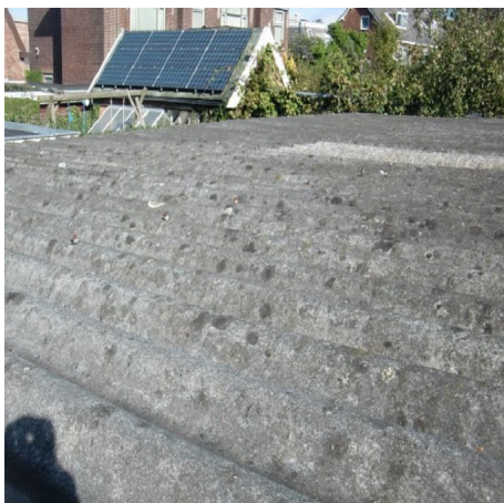
Aanzicht bovenzijde dakbeplating.
