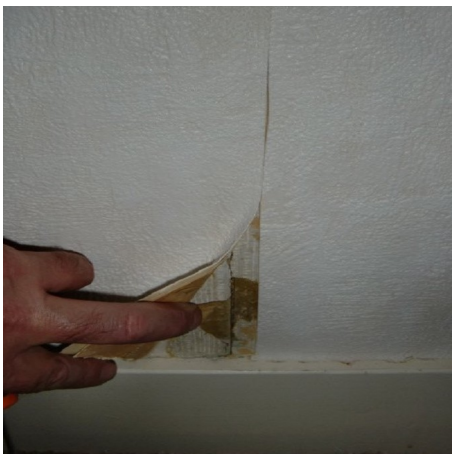
Aanzicht asbesthoudende voorzetwand.
