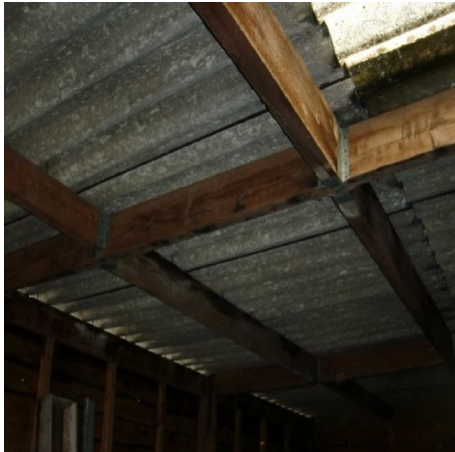
Aanzicht onderzijde dakbeplating.
