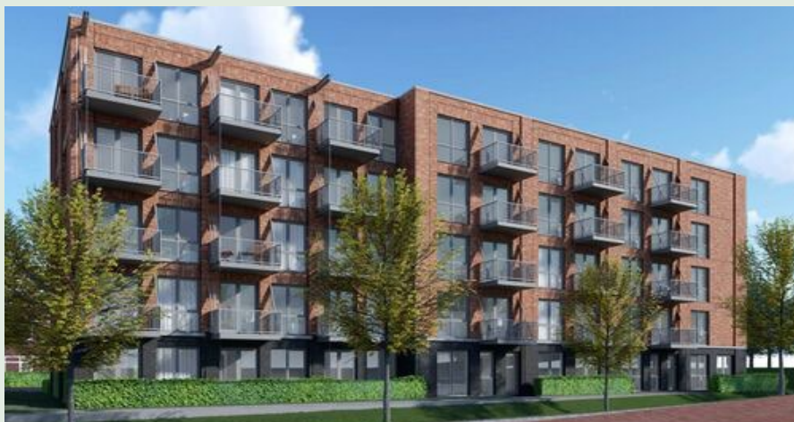
Appartementen aan de Trompweg
