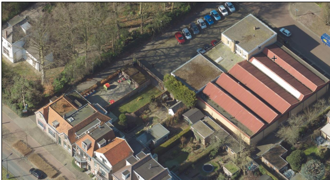
Figuur 9: Luchtfoto met het kinderdagverblijf
