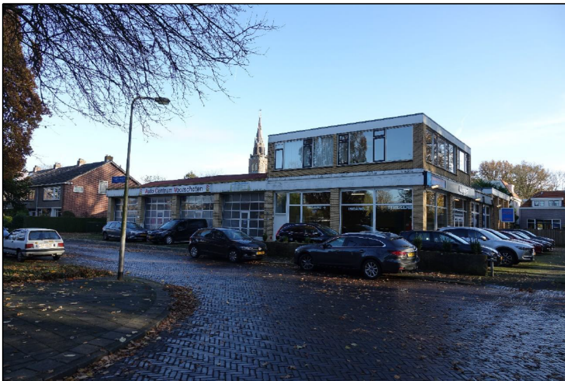
Figuur 2: Zicht op de bebouwing in het plangebied, gezien vanuit de westelijke hoek richting het oosten.
