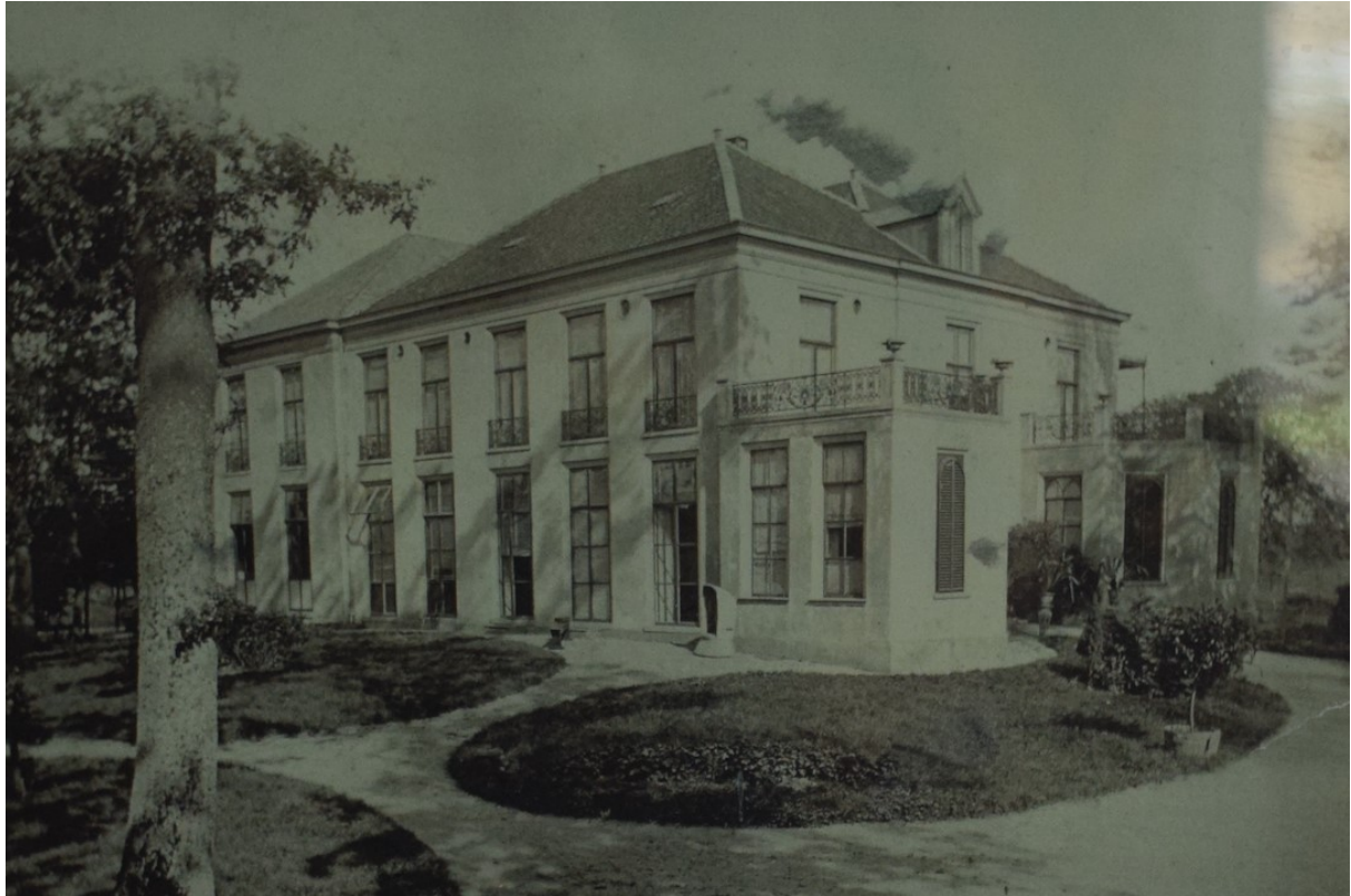
Zijgevel naar de Veurseweg en voorgevel. De hoekuitbouwen zijn al te zien op de kadastrale minuutkaart. De vijf vensterassen komen overeen met de toestand van rond 1700. De kap is een dubbel schilddak met zakgoot, met de verdieping na 1821 gewijzigd in de 19 de eeuw. Het blok aan de achterzijde, onder een eigen kap is rond 1877 gerealiseerd, in wezen een optopping van een eenlaags, een vensteras breed zijvleugeltje.
