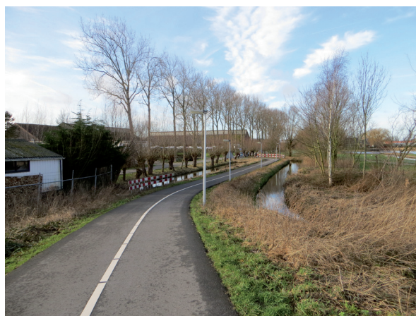
Fietspad vanaf brug over de Vliet, richting Knipplaan gezien.
