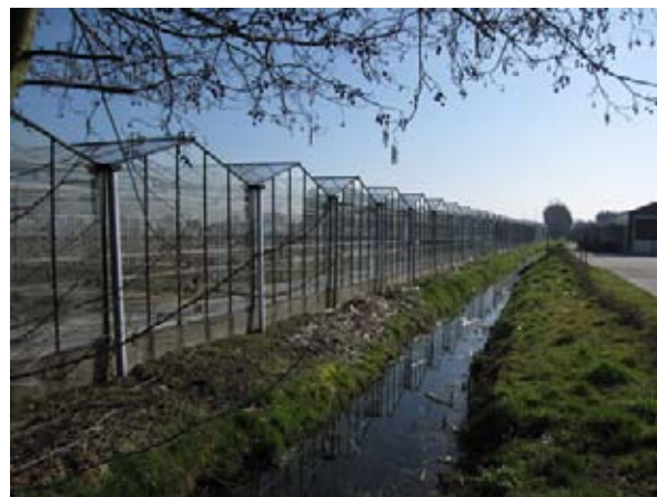
Zuidwestzijde van het kassencomplex met restant van de vaarsloot naar de boerderij.
