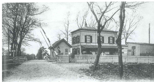
1839 - Station en gelijkvloerse overgang spoor
