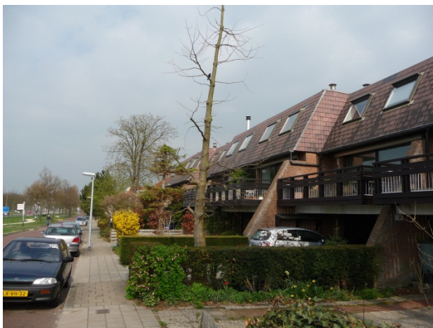
Figuur 3.3: Woningen Papelaan-West 156-168.
