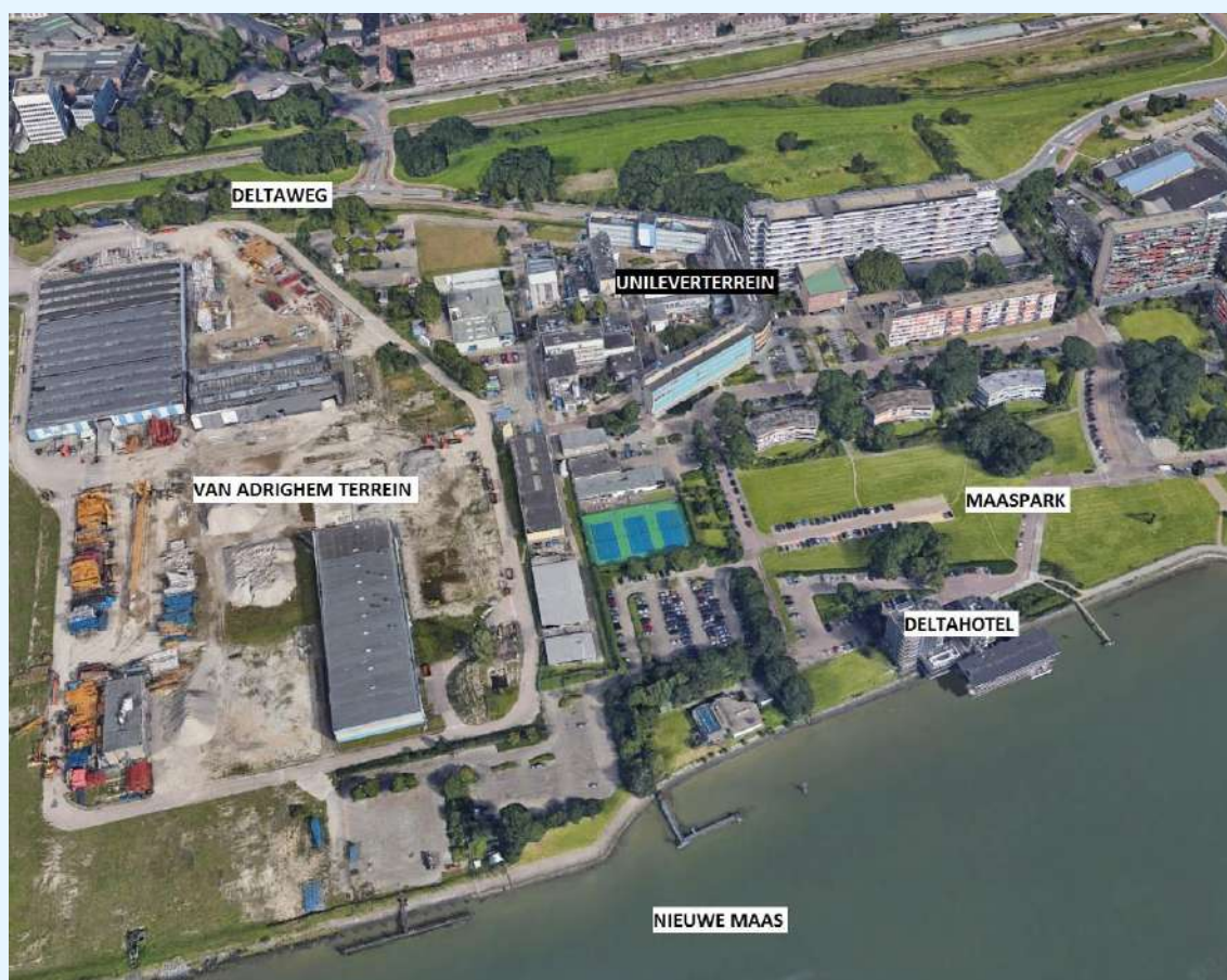
figuur 2: overzicht huidige situatie District-U (foto Google Earth)
