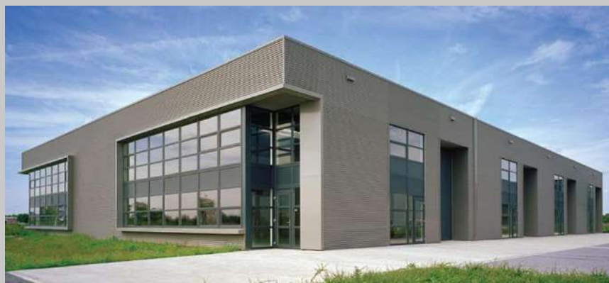
Bron: Plegt, bouwgroep
