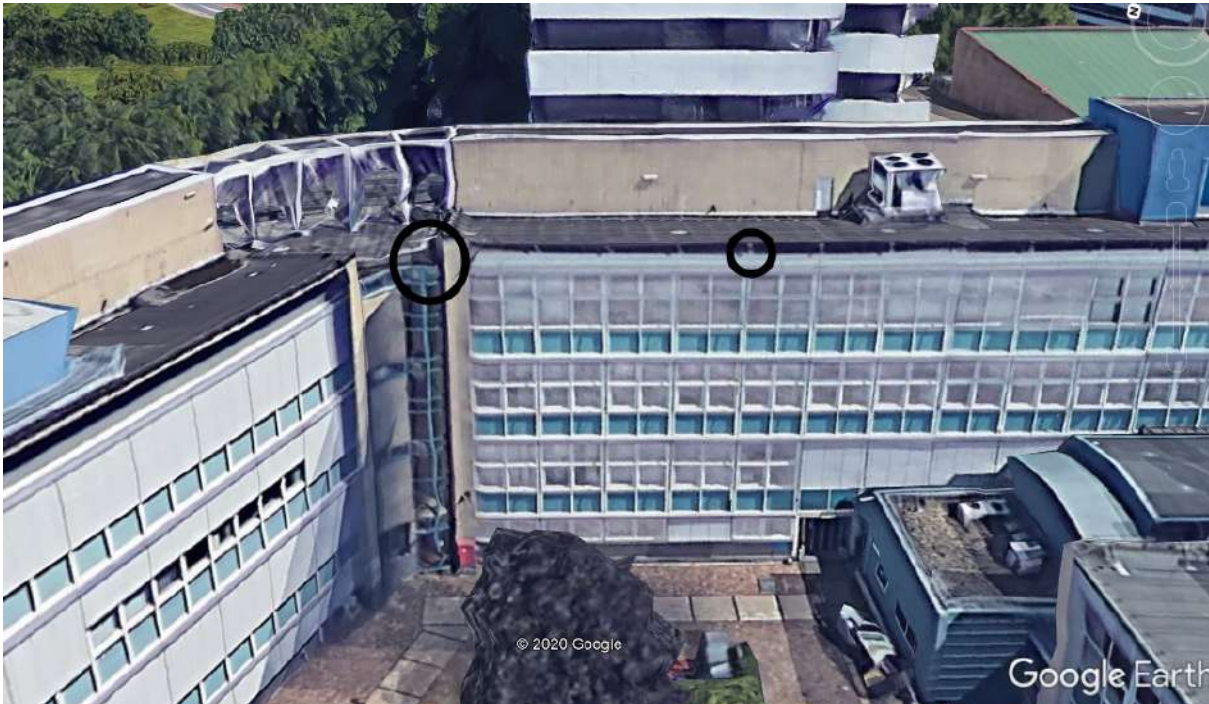
Afbeelding 7. Jaarronde verblijfplaatsen gewone dwergvleermuis. Foto: Google streetview.
