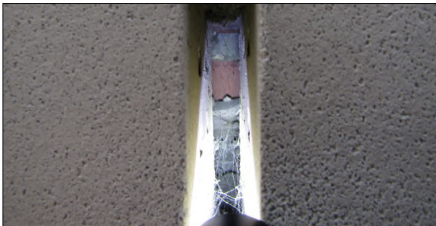
Figuur: op deze foto is duidelijk zichtbaar er een luchtpouw aanwezig is achter de open stootvoegen.
