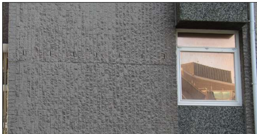
Figuur: de open stootvoegen maken de achterliggende luchtpouw toegankelijk voor vleermuizen.
