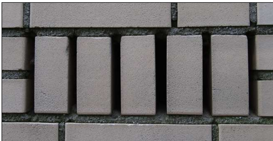
Figuur: de open stootvoegen maken de achterliggende luchtpouw toegankelijk voor zowel dwergvleermuizen, als voor grotere soorten (zoals laatvlieger en meervleermuis).
