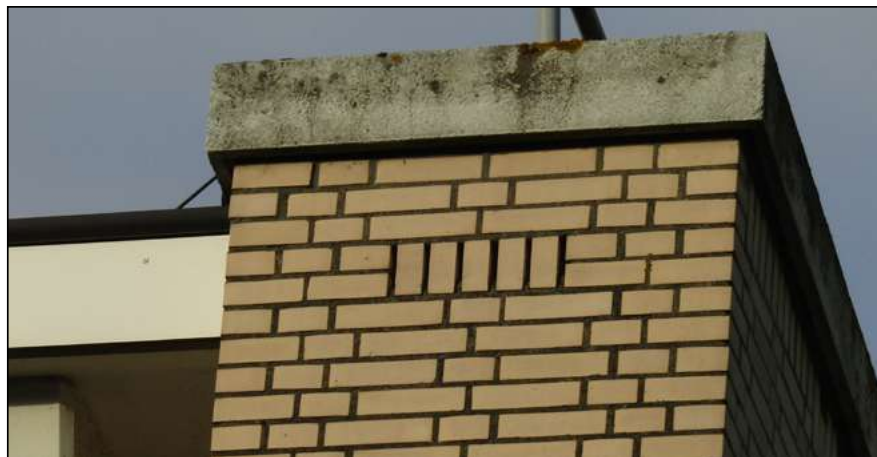
Figuur: de open stootvoegen bieden geschikte invliegopeningen voor vleermuizen, die verblijfplaatsen in de luchtpouw kunnen hebben.
