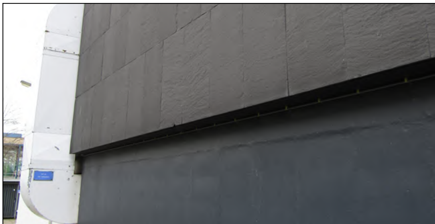
Figuur: achter de beplating is een open ruimte aanwezig, welke via de onderzijde toegankelijk is voor vleermuizen.
