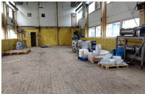
Foto 1: Binnenzijde gebouw D
