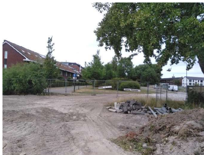
Foto 6. Bouwterrein met kaal zand aan de Graaf Arnulfstraat, gefotografeerd in noordelijke richting.
