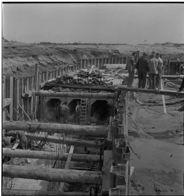
Figuur 9: Aanleg van pipleidingen medio 1955
