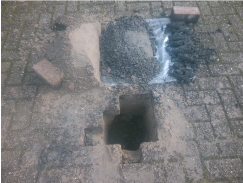
Foto 5: asbestinspectiegat 7
