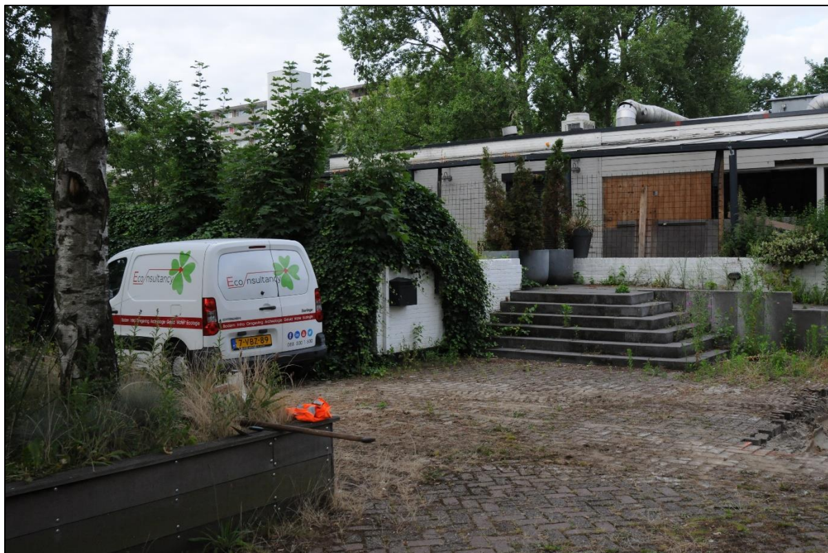
Figuur 2. Plangebied voor aanvang van de werkzaamheden.
