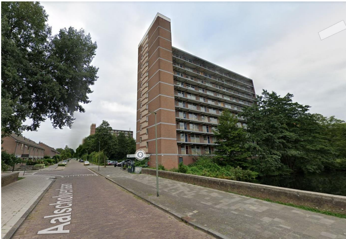
Afbeelding 2.3: Impressie Aalscholverlaan met één van de te renoveren flats.
