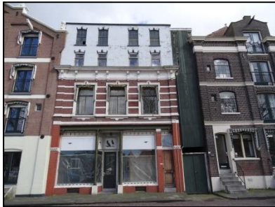
Figuur 3. Voorzijde (westelijke gevel) van het pand op de onderzoekslocatie.
