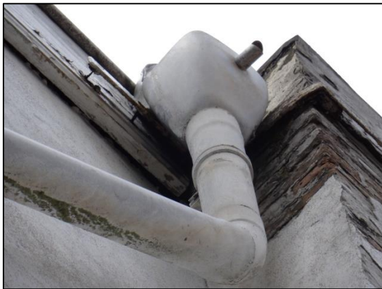
Figuur 12. Ruimte tussen het boeiboord, de regenpijp en de oostelijke gevel van het pand op de onderzoekslocatie.
