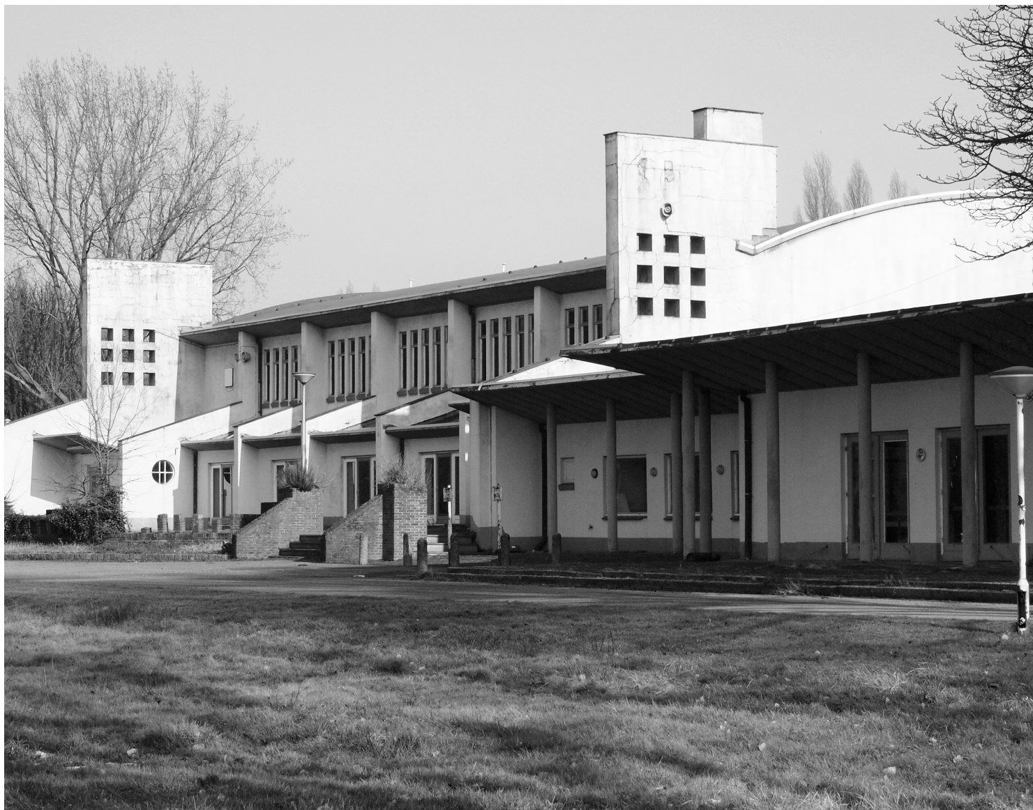
Foto's van het sportcomplex Park Vijfsluizen
