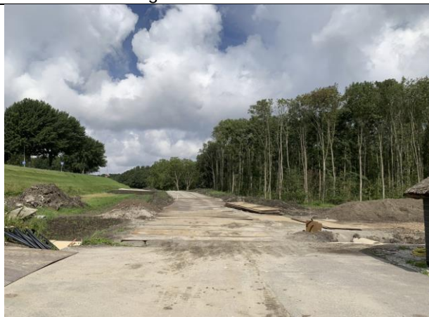
Aanleg nieuwe ontsluiting naar Maassluissedijk
