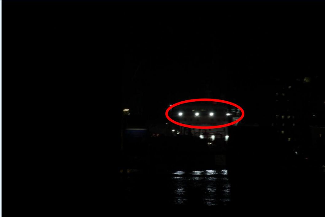
figuur 5: armaturen gemeten op locatie 2. De betreffende armaturen zijn met een rode omranding aangegeven.
