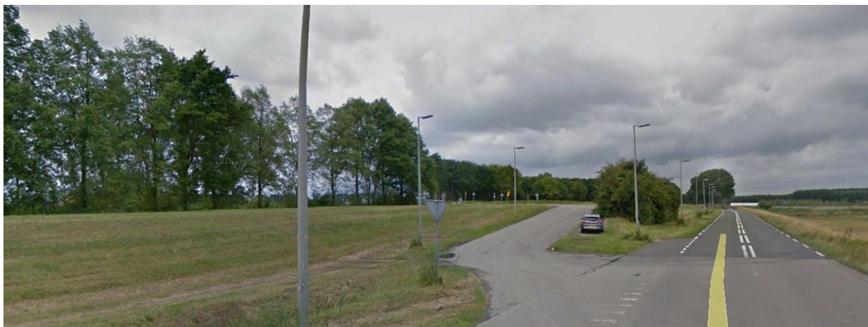
Figuur 3-2 Zicht op de dijk en de dijkovergang vanaf de Maassluissedijk tussen Vlaardingen en Maassluis (bron: Google Earth)
