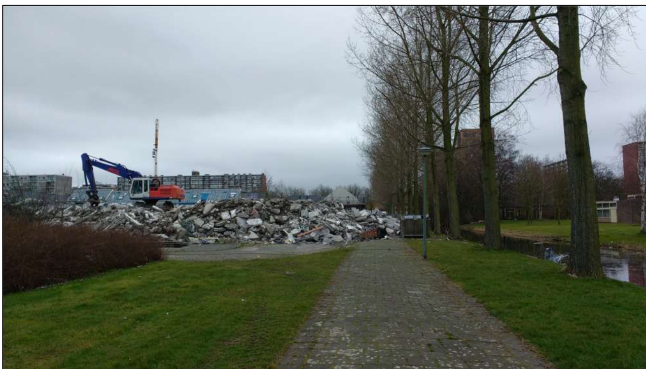
Figuur 4. Representatieve doorsnede van het plangebied: watergang, bomenrij, gazon, gesloopte bebouwing en struweel. Op de achtergrond nieuwbouw.
