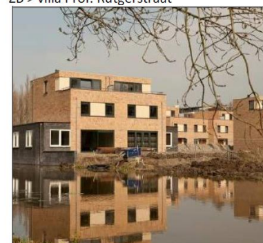
Nieuwbouw De Eilanden / Hugo de Vriesstr
