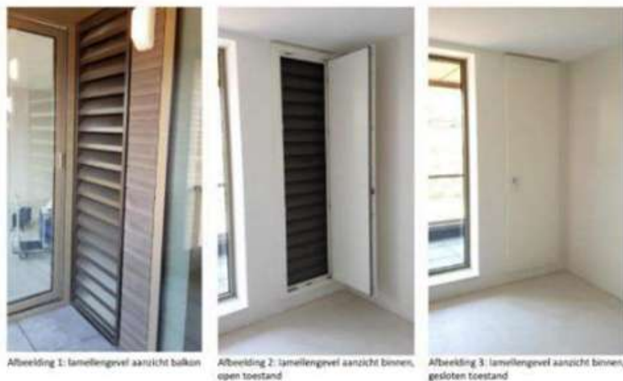
Figuur 4.5 Principe geluidwerend louver (Comfortbox) aan de binnenzijde afsluitbaar
