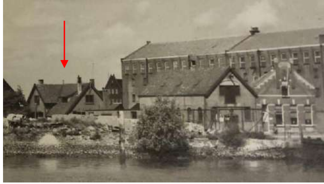
Links achter het woonhuis bij nr. 22-23, SAV T286ZZ-012
