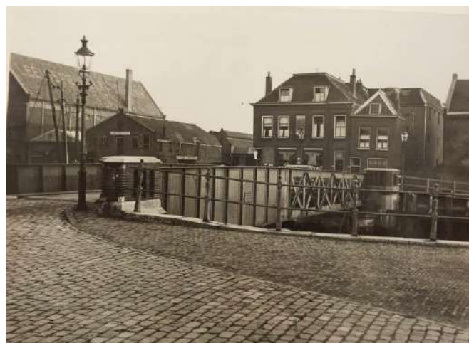
Poffertjesbrug naar de overzijde van de Oosthavenkade. SAV T286ZZ-15
