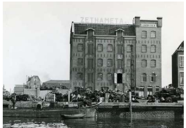
Pakhuys Zethameta met linksachter het woonhuis aan de waterleidingstraat. SAV T286ZZ-073-2
