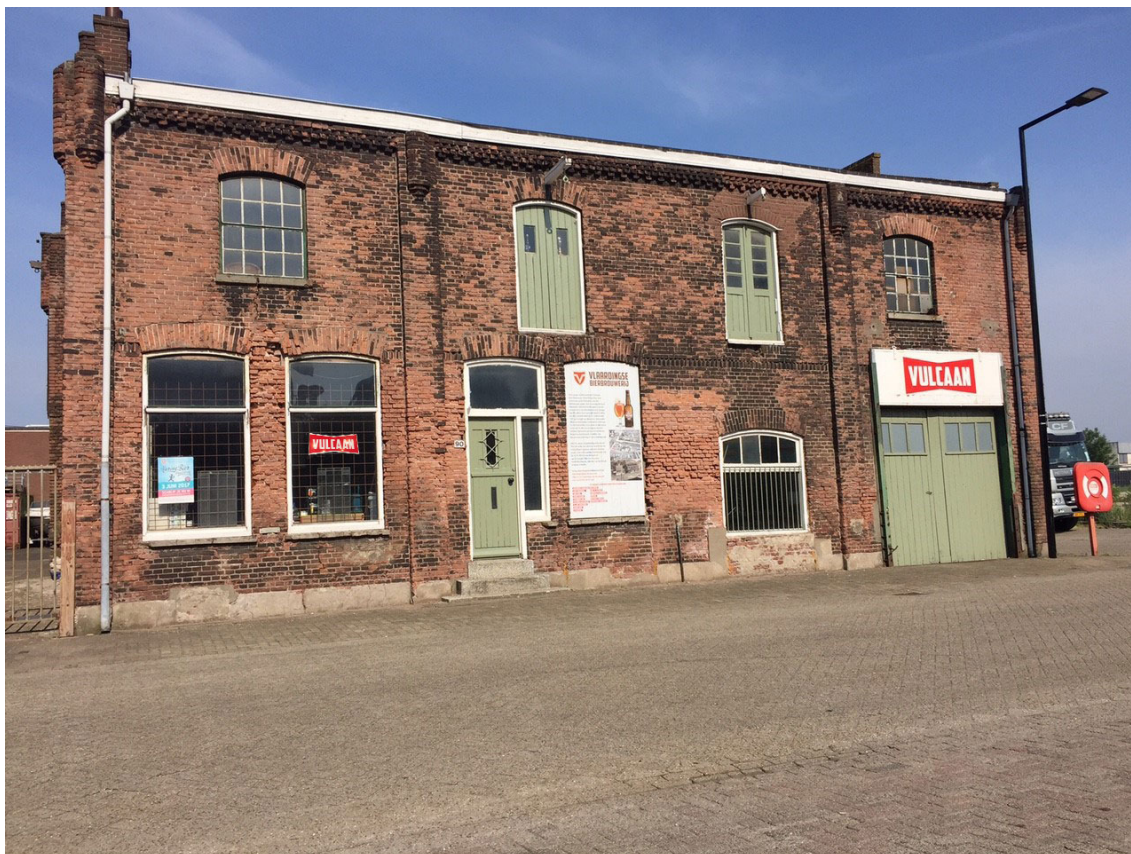
Figuur 2.1 Gevelaanzicht in de huidige situatie aan de Oosthavenkade 90-92
