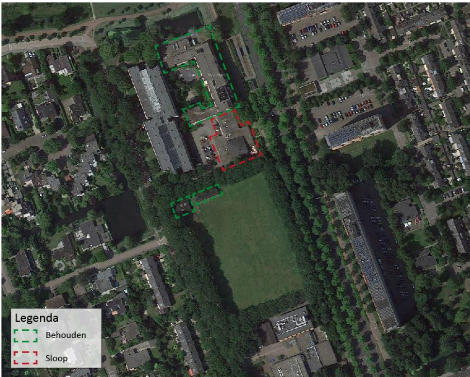
Afbeelding 2: te slopen bebouwing
