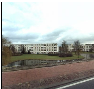
Zuidelijk deel: De Snaaijer portiekflats
