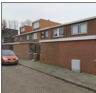
Zuidelijk deel: dakopbouw (Pompenburgsingel).
