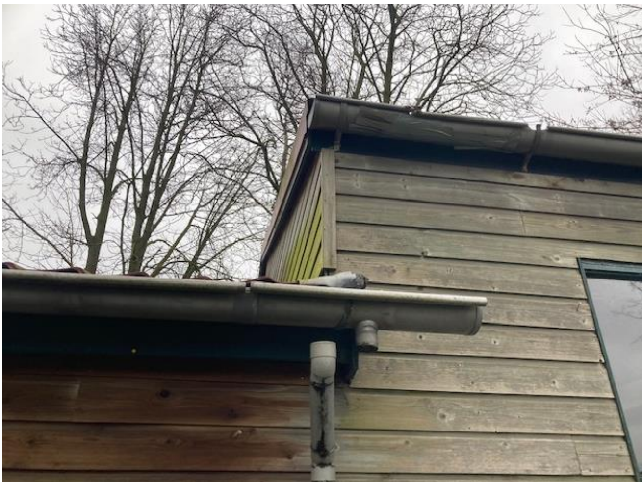
Afbeelding 4.2 impressie plangebied (te amoveren opstallen (hermetisch afgetimmerd waardoor er geen wegkruipmogelijkheden zijn voor vleermuizen).
