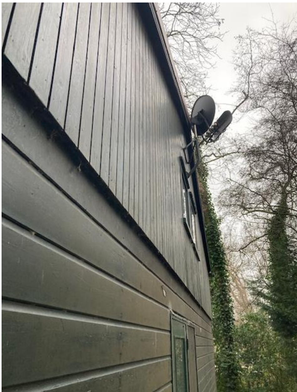
Afbeelding 4.3 impressie plangebied (te amoveren opstallen (hermetisch afgetimmerd waardoor er geen wegkruipmogelijkheden zijn voor vleermuizen).
